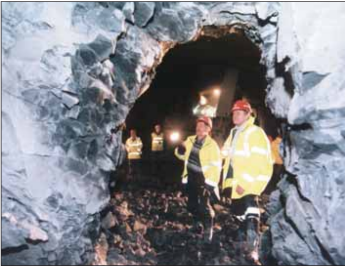
Obr. 4 Prorážka klimkovického tunelu Fig. 4 Klimkovic tunnel breakthrough
