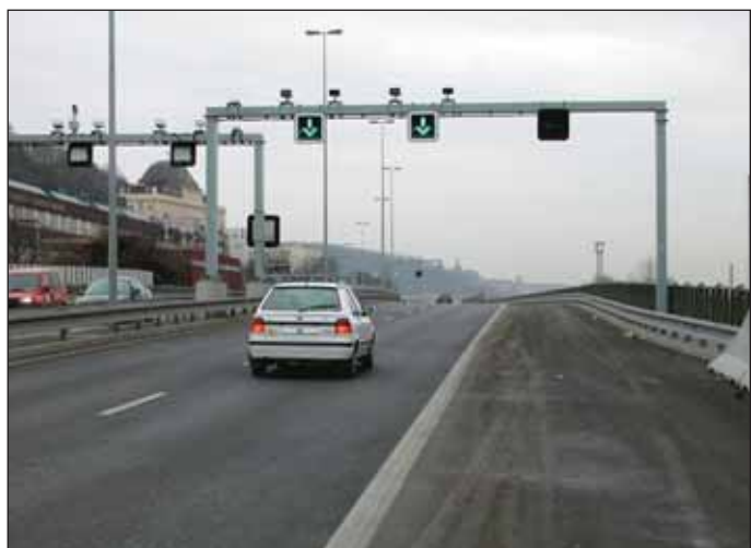
Obr. 2 Kamery zařízení pro měření úsekové rychlosti za podjezdem Zlíchov - Radlická
