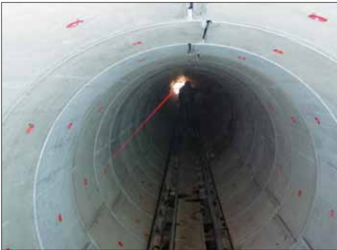
Obr. 5 Ostění štoly budované pomocí mechanizovaného štítu Fig. 5 The gallery lining installed by the TDM
