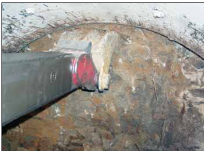
Obr. 2 Zařízení pro rozpojování zemin a hornin třídy těžitelnosti 2 – 5 Fig. 2 Ground disintegration equipment for excavation classes 2 – 5
