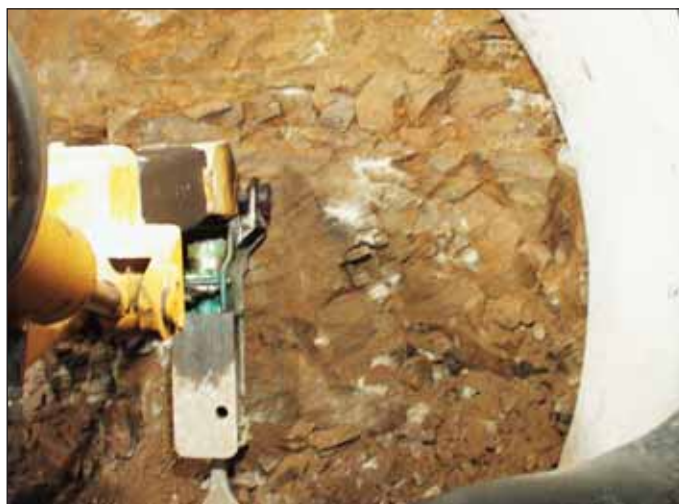
Obr. 3 Kladivo na výložníku pro rozpojování skalních hornin třídy těžitelnosti 6 – 7 Fig. 3 The impact breaker disintegrating rock within excavation classes 6 – 7
