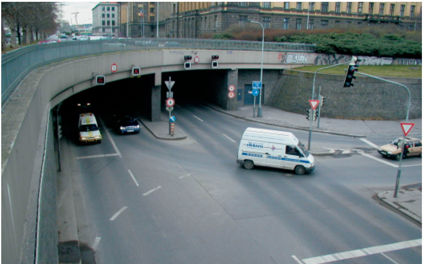
Obr. 1 Vjezd do Těšnovského tunelu z nábřeží Ludvíka Svobody
