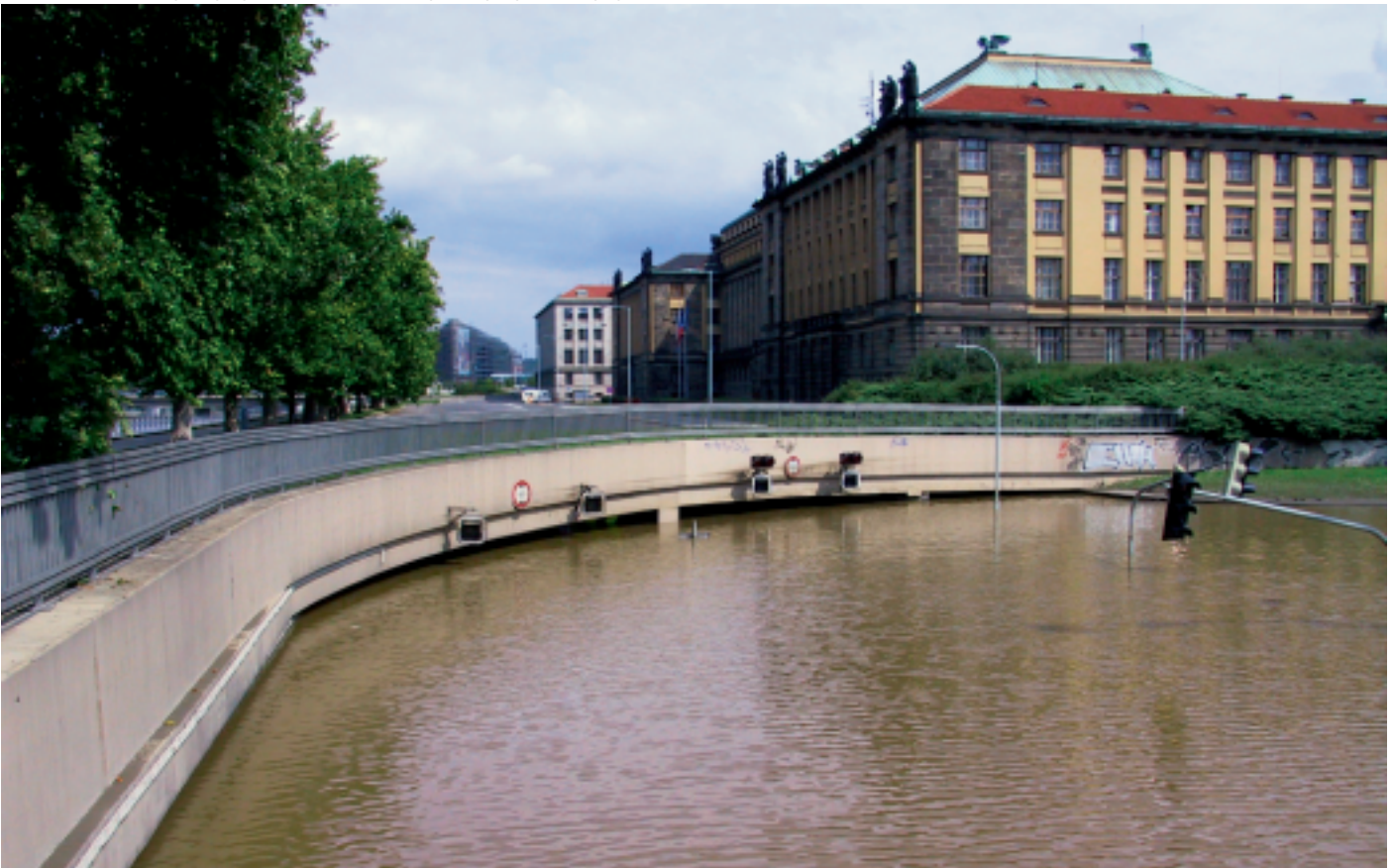
Obr. 2 Zaplavený Těšnovský tunel (autorka snímku Ing. Věra Šottová)
