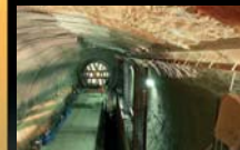
Královopolský Tunnel, Large Municipal Ring Road Brno
