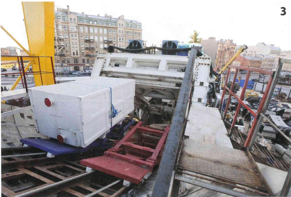
Die Lösung für den Materialtransport bei 30° Neigung: ein System mit 2 Winden und gleisgebundenen Wägen
