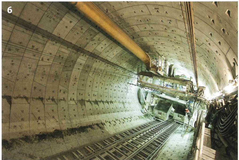
Tübbingausbau: Ringteilung, 7+1, Länge 1.000 mm, Dicke 500 mm
