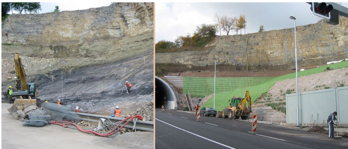
Obr. 4.33 Odtěžení zemin (hornin), nahrazení geobuňkami, kotvení skalního odřezu
