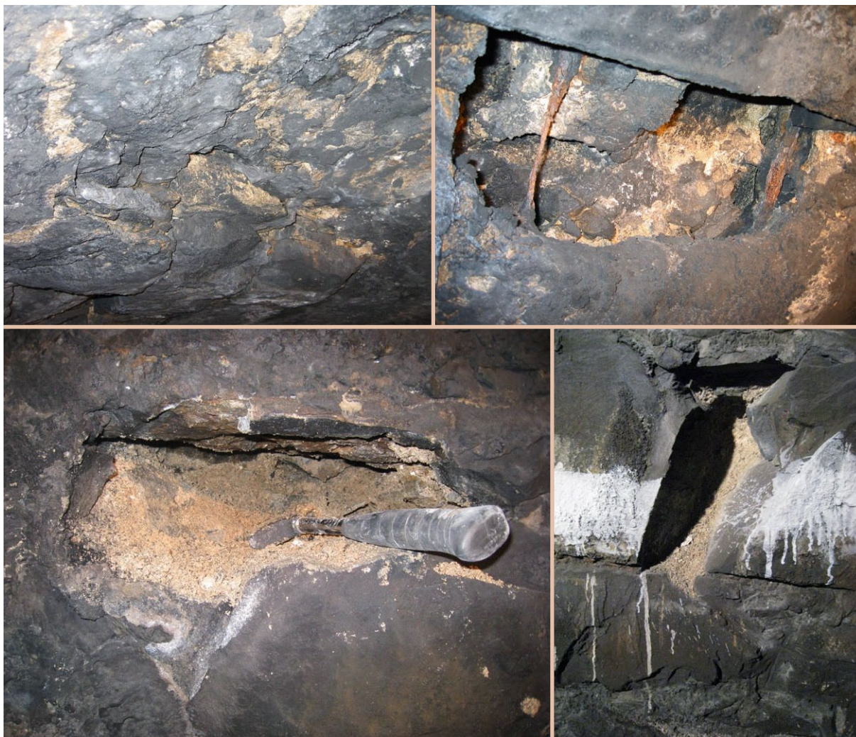
Obr. 4.29 Vypadávání zdících kamenů, rozpad materiálu ostění
