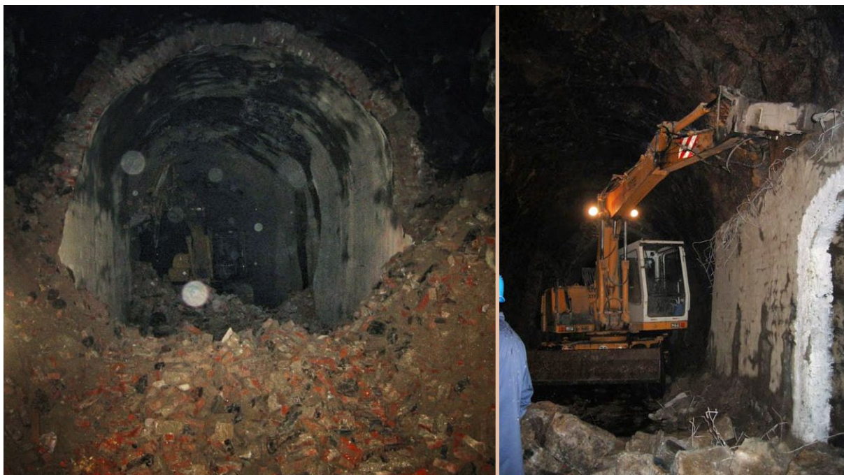
Obr. 4.16 Bourání stávající obezdívky
