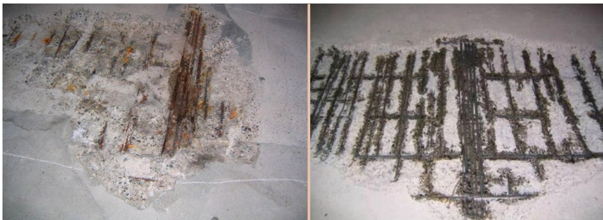
Obr. 4.41 Pasivace výztuže - zkorodovaná výztuž vlevo, po nátěru inhibitorem koroze vpravo
