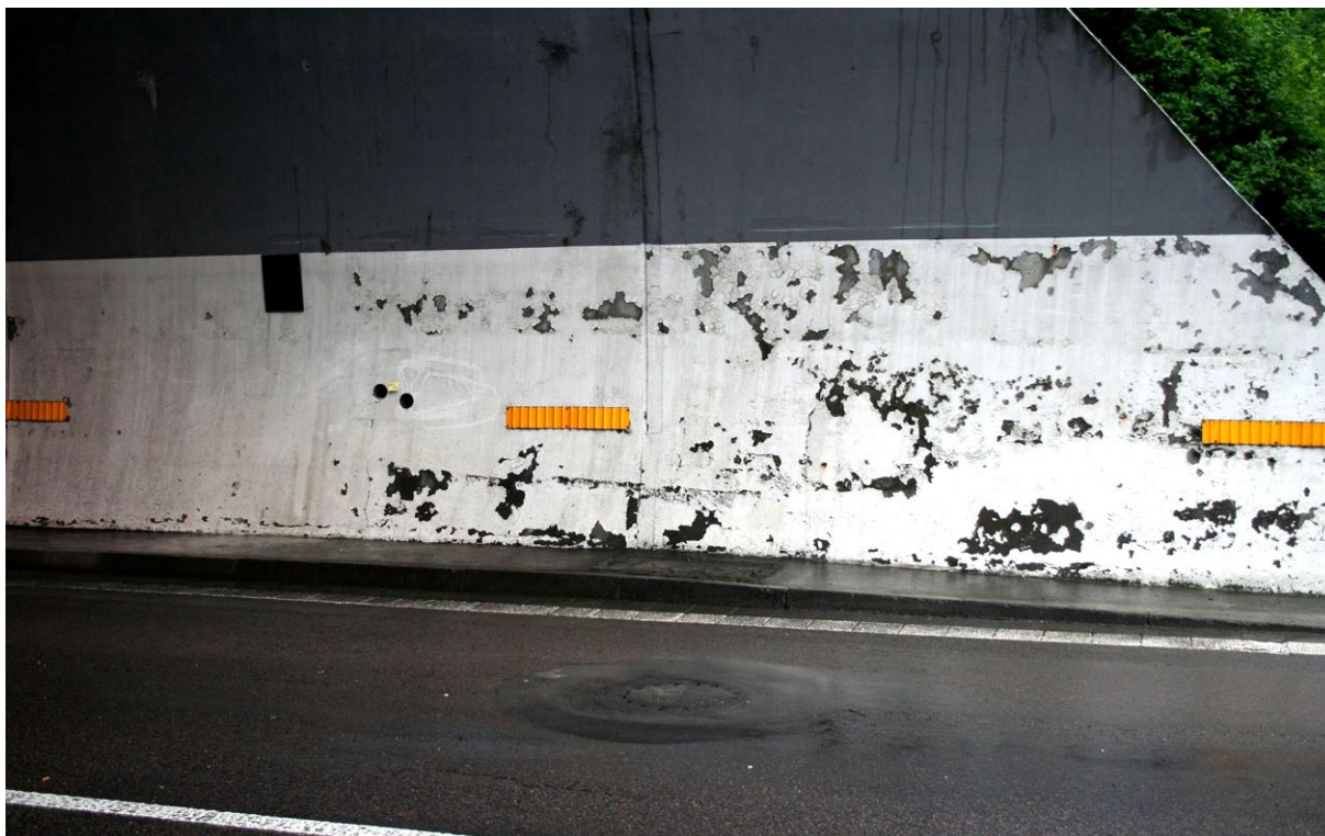
Obr. 4.38 Povrchová degradace způsobená agresivitou CHRL
