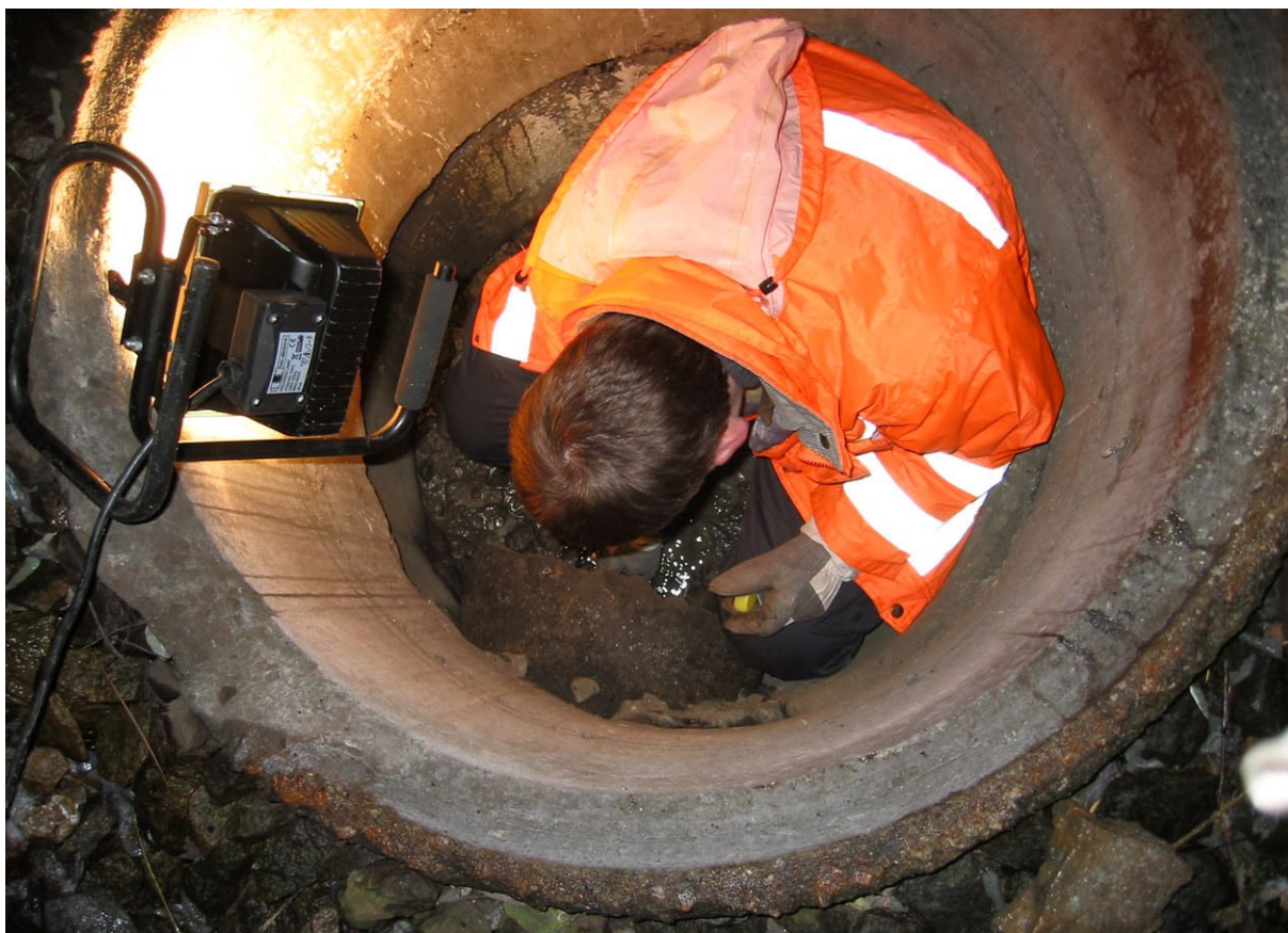
Obr. 3.20 Odběr vzorku vody z revizní šachty v kolejovém loži
