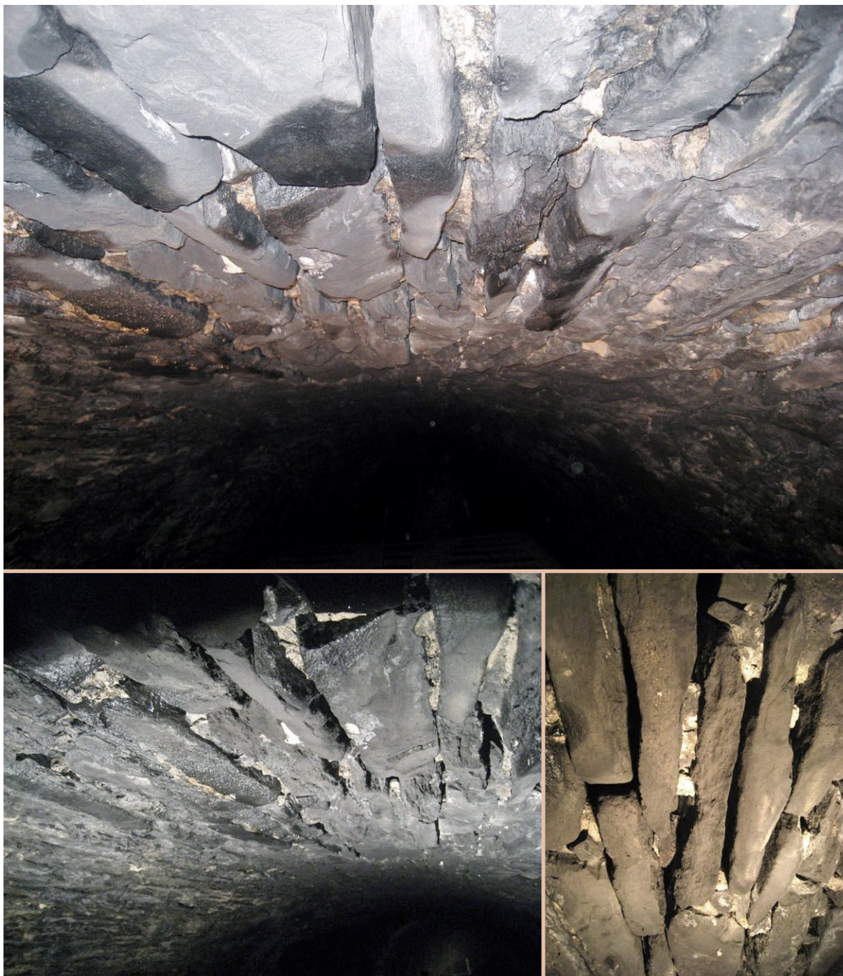
Obr. 4.27 Prázdné spáry - ohrožení stability tunelového ostění
