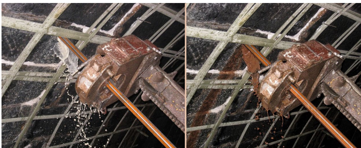
Obr. 3.10 Při vrtání lze podle odporu prostředí a podle výplachu zjistit stav materiálu za ostěním
