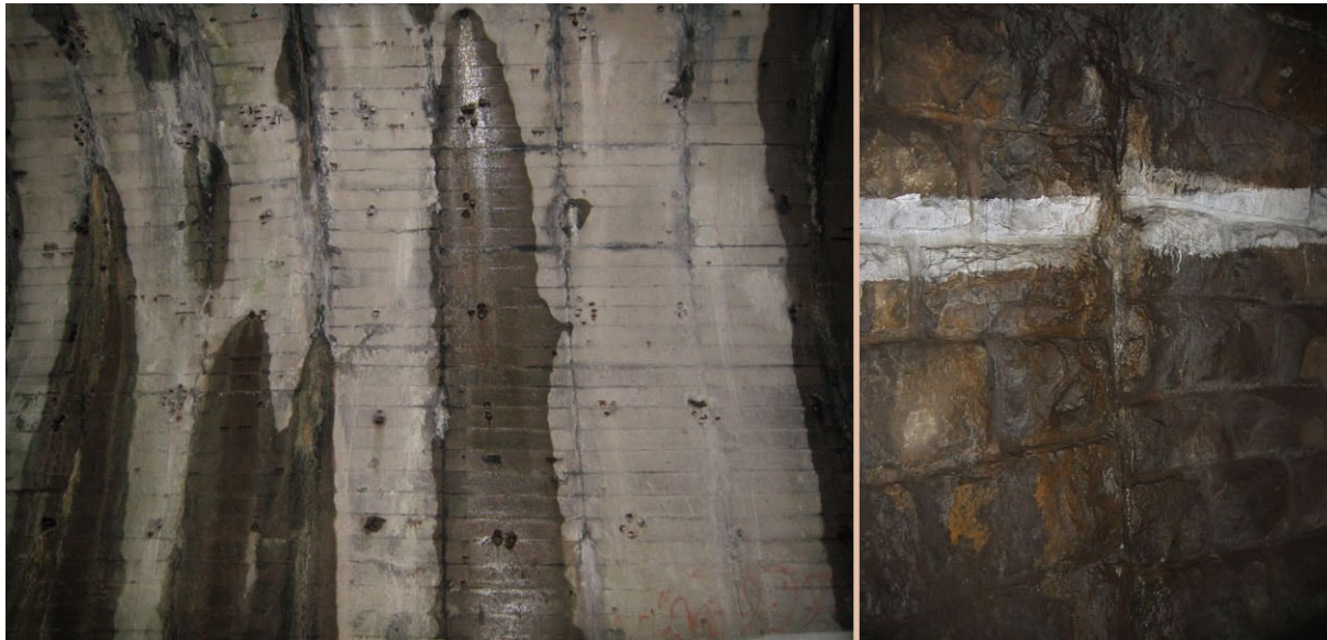
Obr. 4.3 Lokální výrony vody, řešitelné svodnicemi
