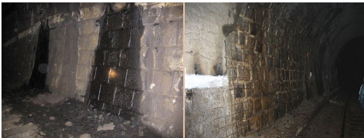
Obr. 4.1 Příklady plošného zamokření
