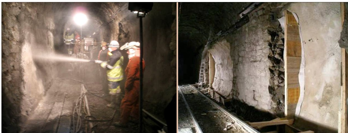
Obr. 4.22 Stříkaná hydroizolace prováděná po pásích systémem sudá x lichá
