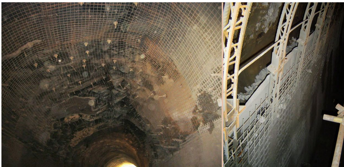
Obr. 4.17 Nové ostění s rubovou drenáží (nopová fólie, štěrk) a hydroizolační vrstvou
