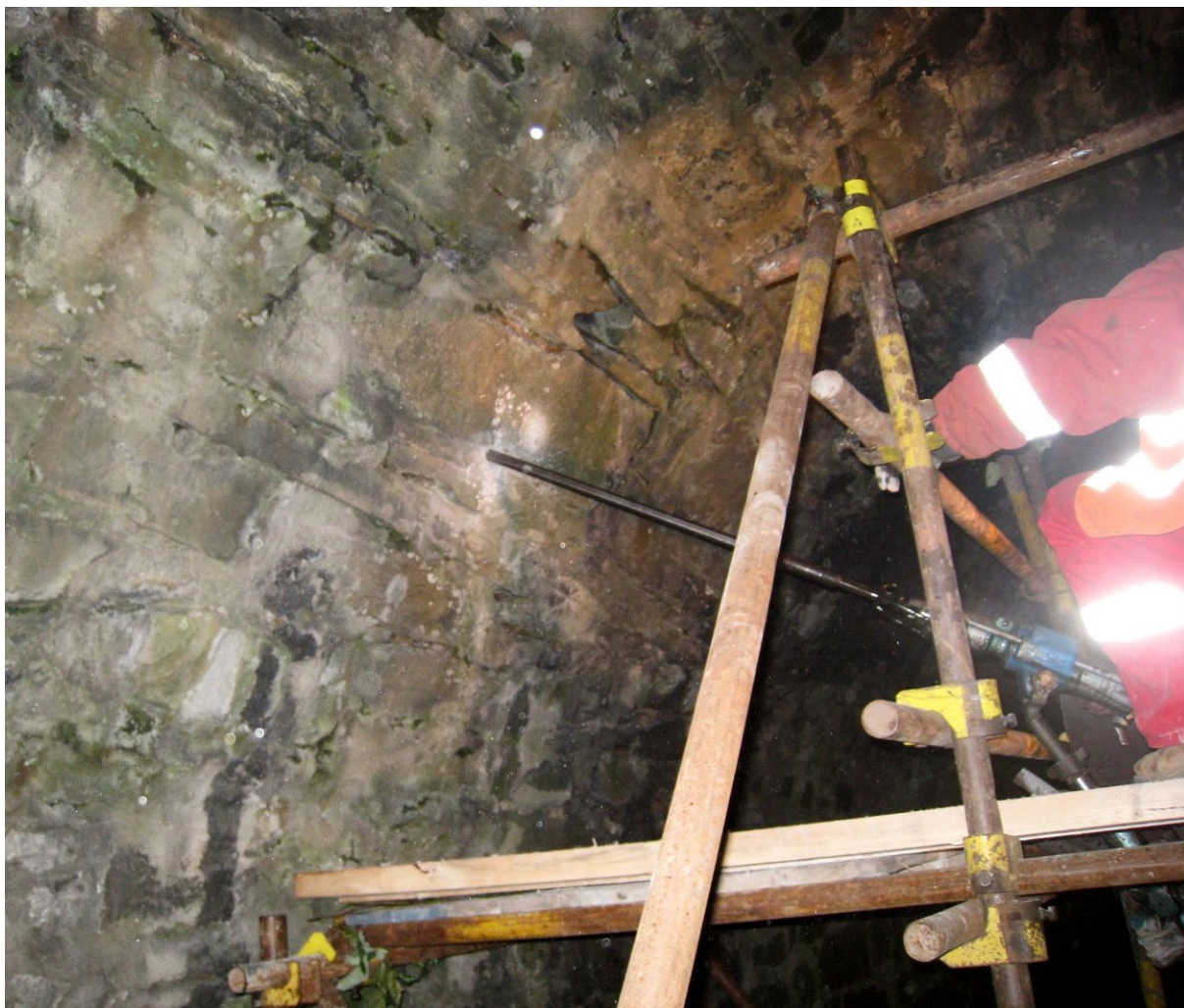
Obr. 3.9 Bezjádrový průzkumný vrt
