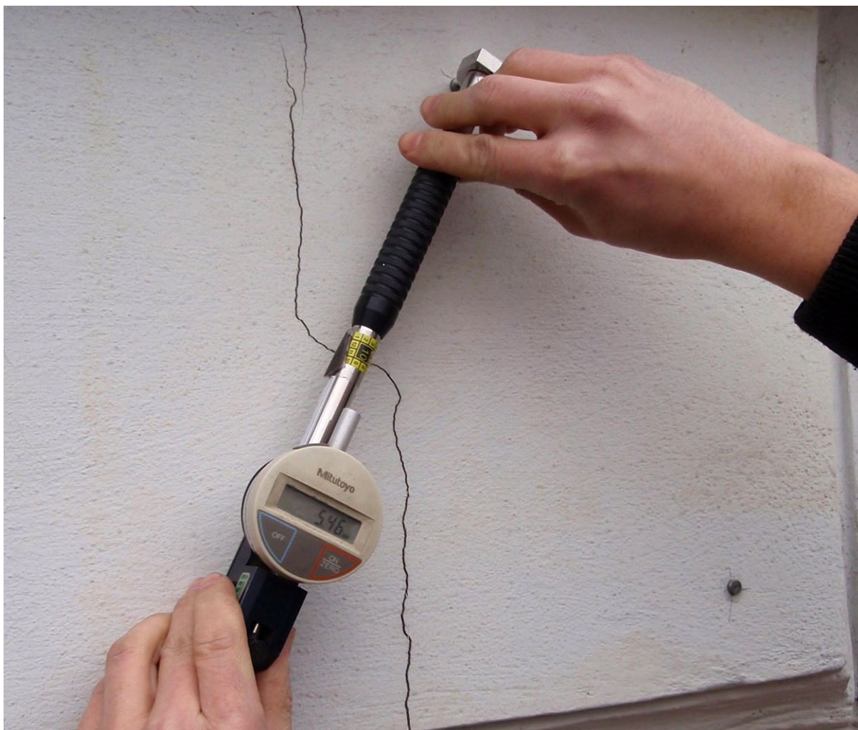
Obr. 3.15 Měření trhlin dilatometrem - vzájemný posun hřebů ve třech směrech
