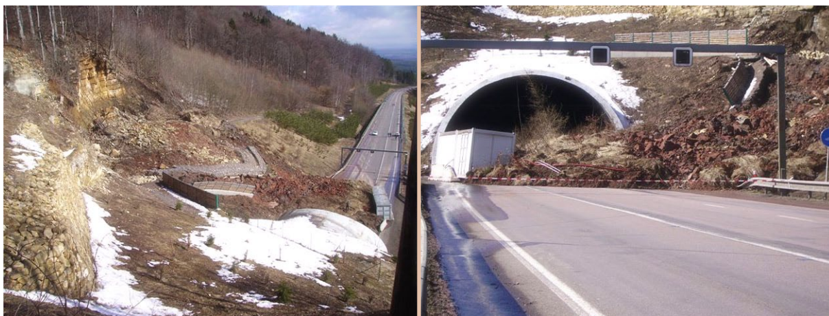
Obr. 4.31 Sesuv svahu u portálu tunelu - ohrožení bezpečnosti, zablokování provozu
