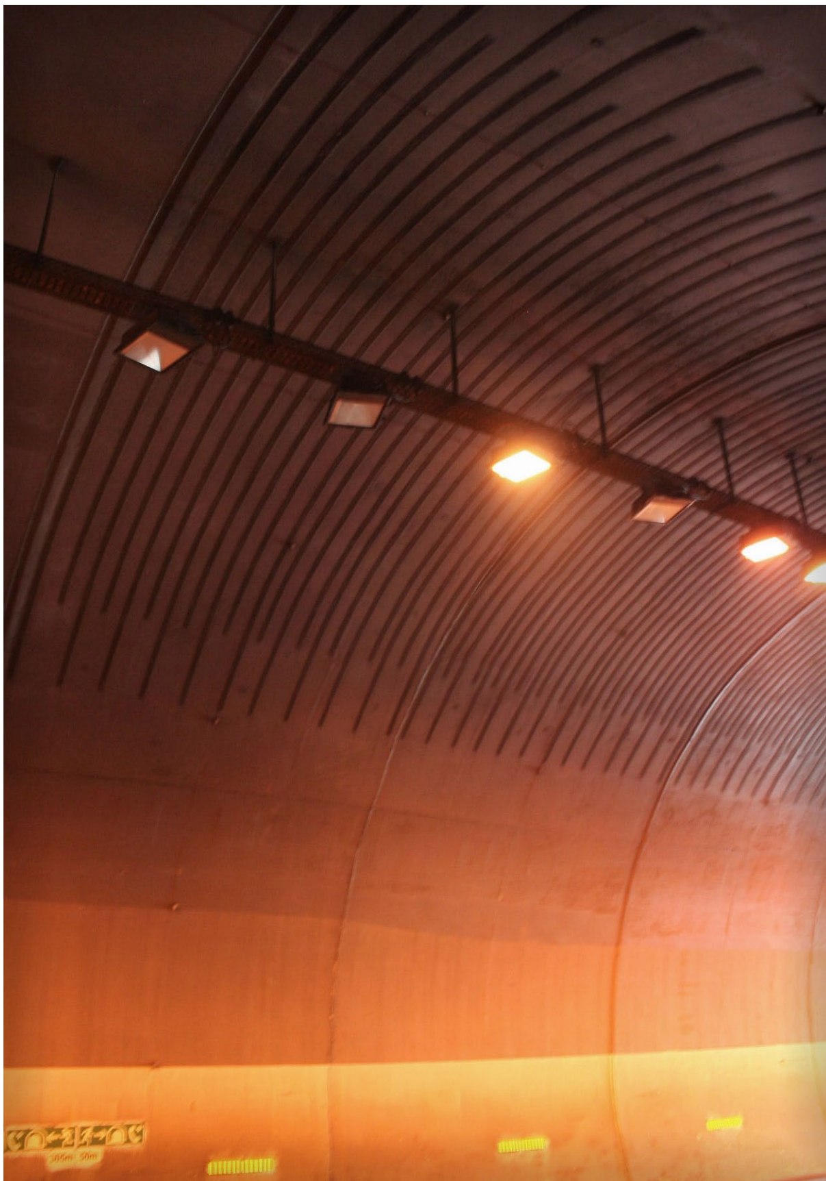
Obr. 4.43 Využití lepených výztužných lamel pro zesílení ostění tunelu v klenbě
