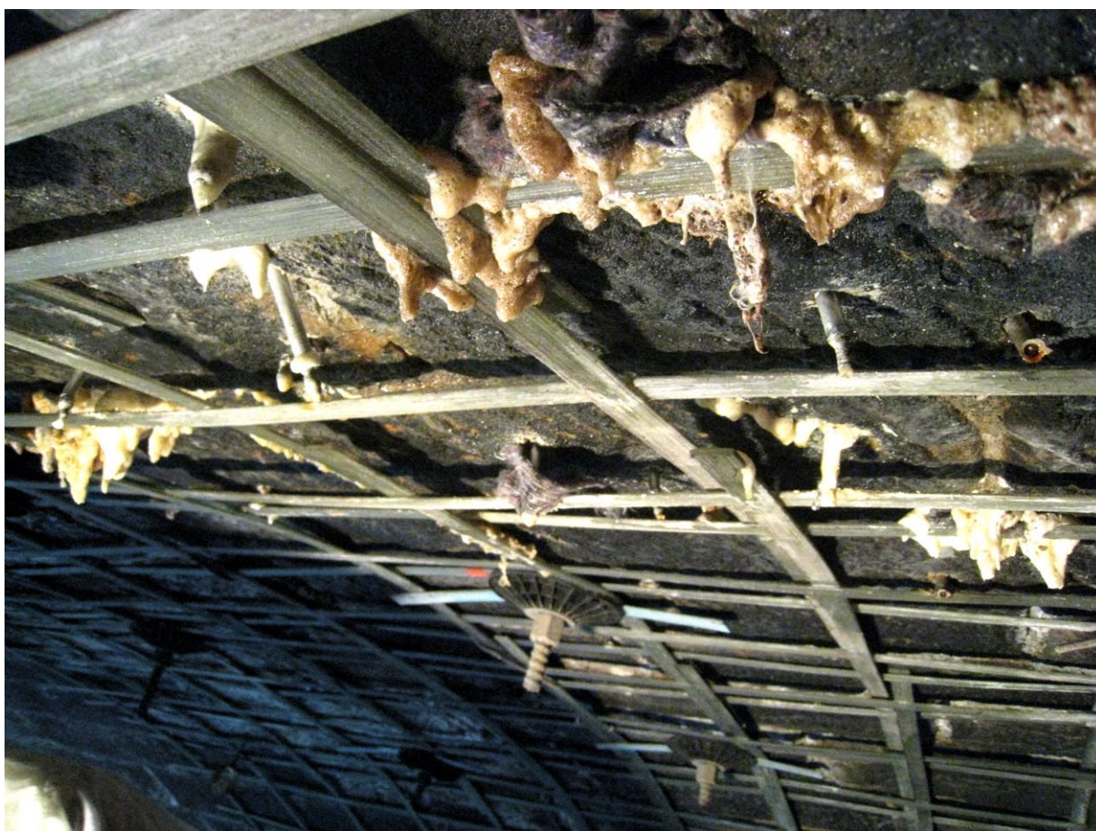
Obr. 4.6 Těsnící injektáž - podle vytečeného materiálu lze upravovat rozsah injektáží
