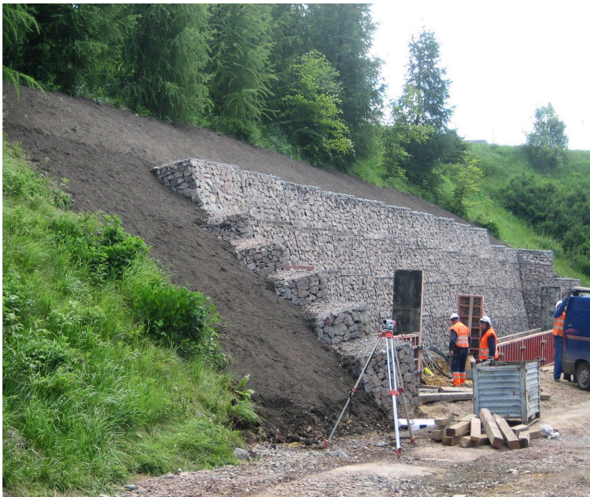
Obr. 4.32 Nová zárubní zeď, zlepšený zásyp za a kolem zdi
