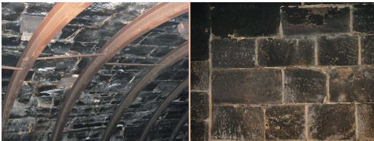
Obr. 4.30 Příklady navětralého spárování - malta drží ve spárách, ale drolí se
