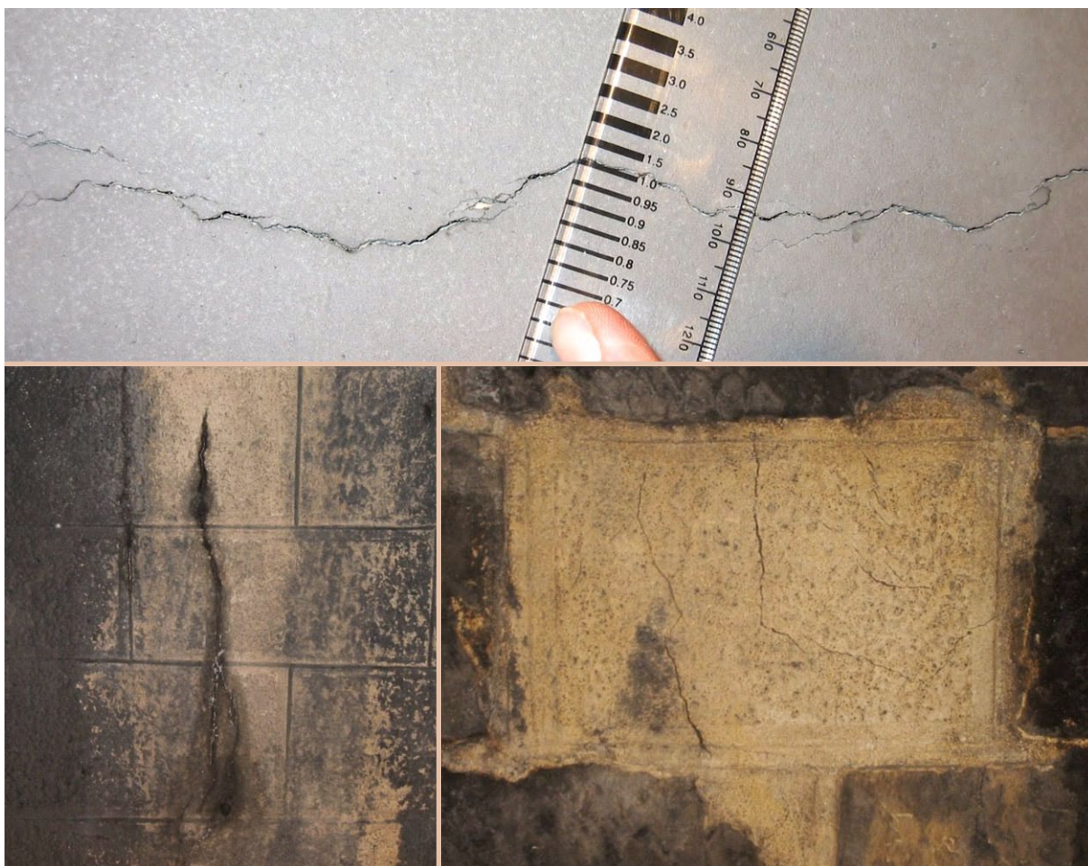
Obr. 4.35 Příklad trhlín v materiálu ostění (beton, kamenná obezdívka)
