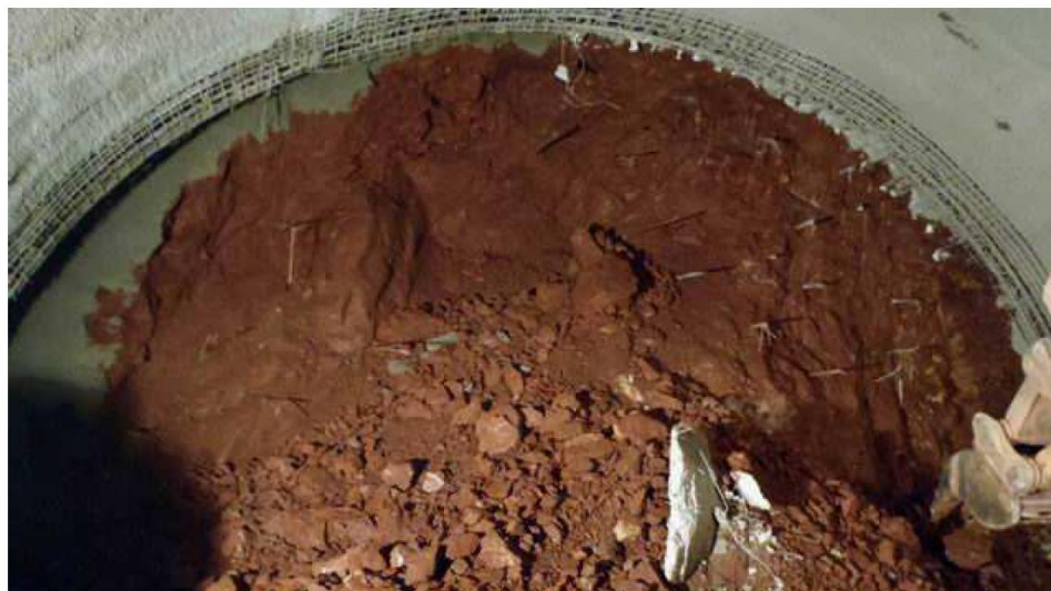
Obrázek 6: Nesoudržná čelba typu 7a vyžadovala ražbu v krocích po 0,5m, jehlování příp. mikropilotový deštník DN 114, přidavné radiální kotvy dl. 8m, stabilizaci čelby torkretem a laminátovými kotvami a okamžité provádění protiklenby
