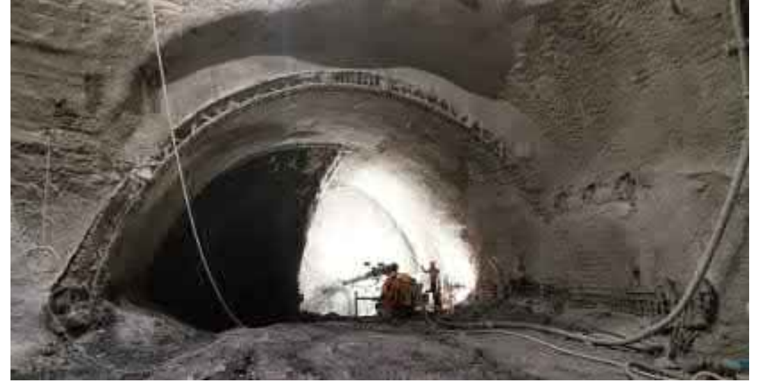
Ražba kaloty propojky sever do levého i pravého staničního tunelu 09/2023
