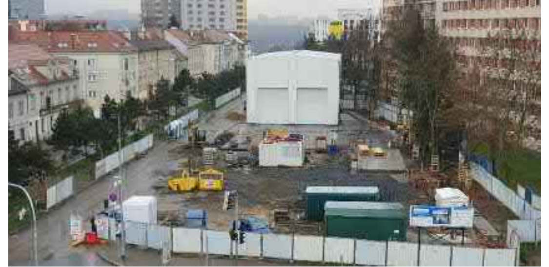
Hloubení pod ochrannou protihlukové haly 12/2022
