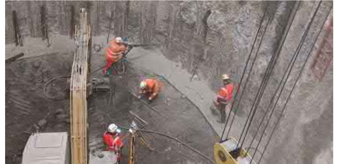
Zaměřování vrtů propojovací výztuže převrtávaných pilot a druhé převázky v šachtě 01/2023
