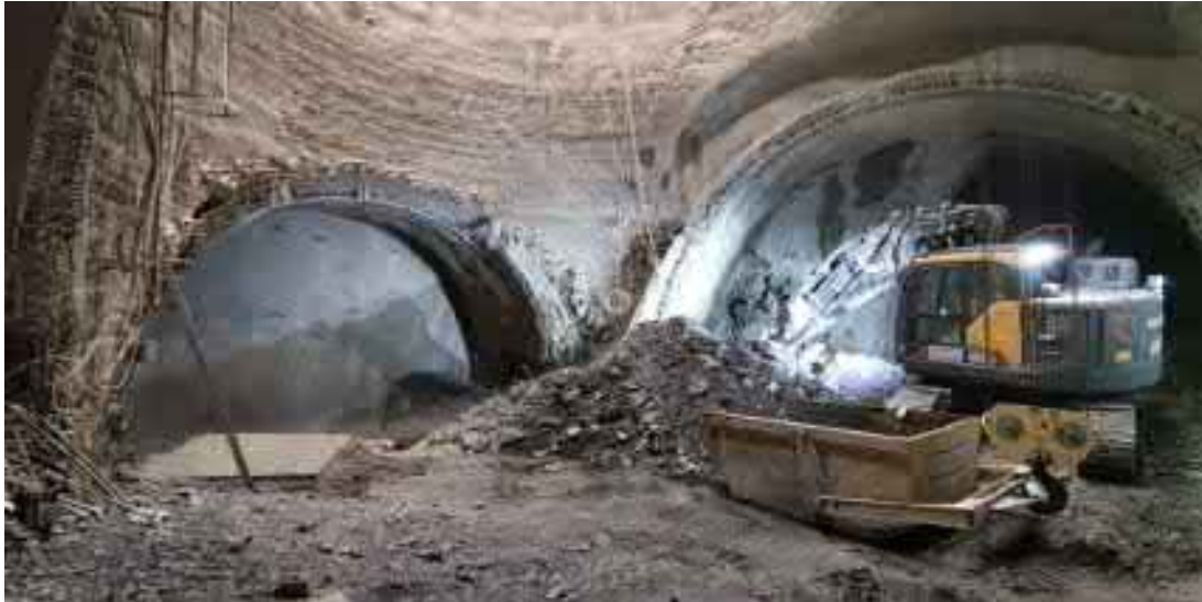
Provedení zarážky pro eskalátorový tunel jih 08/2023
