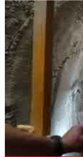
Dokončení ražby kaloty propojky sever do levého staničního tunelu vč. MKP dešťníků 10/2022
