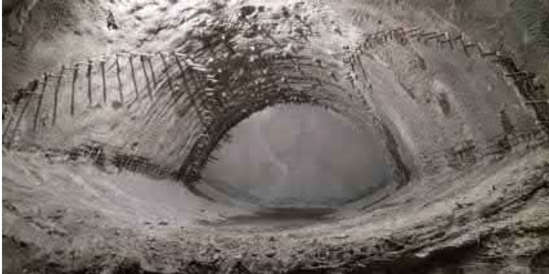
Dokončení ražby kaloty propojky sever do pravého staničního tunelu vč. MKP deštníků 10/2022
