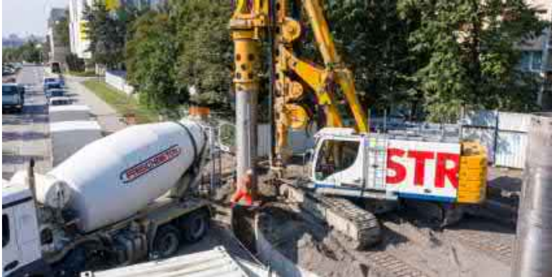
Betonáž pilot šachty pro výstavbu stanice 08/2022
