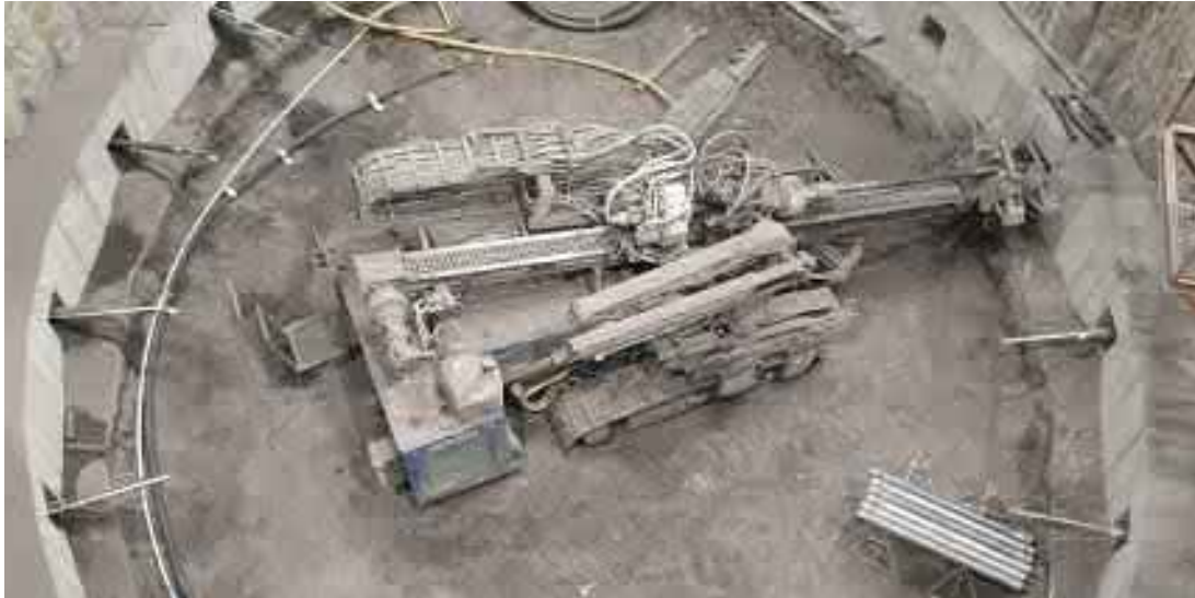
Vrtání a instalace lanových kotev první převázky 12/2022
