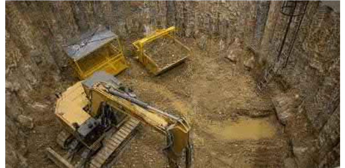
Hloubení v šachtě z převrtávaných pilot 11/2022
