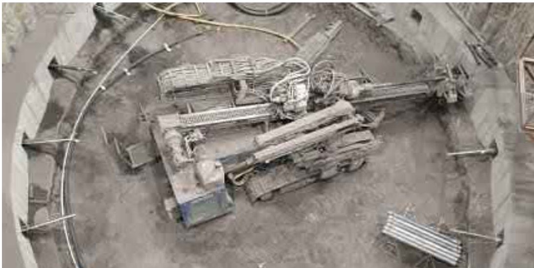
Vrtání a instalace lanových kotev první převázky 12/2022
