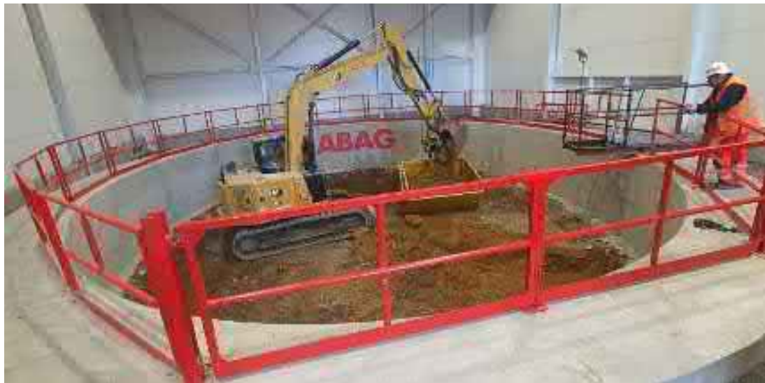
Zahájení hloubení v protihlukové hale 11/2022
