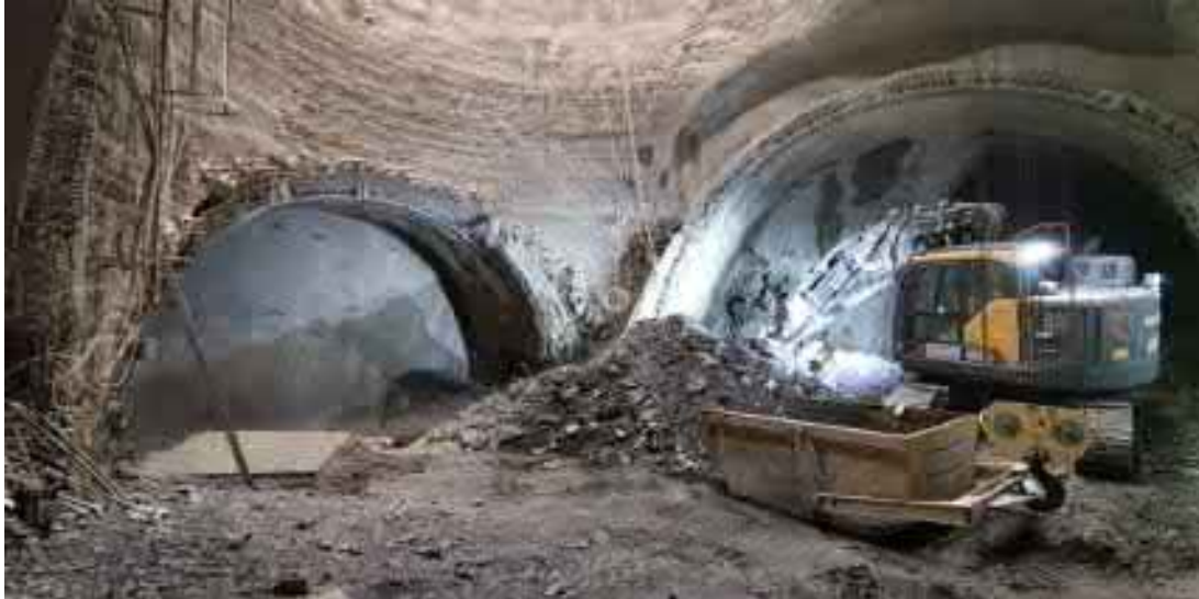
Provedení zarážky pro eskalátorový tunel jih 08/2023
