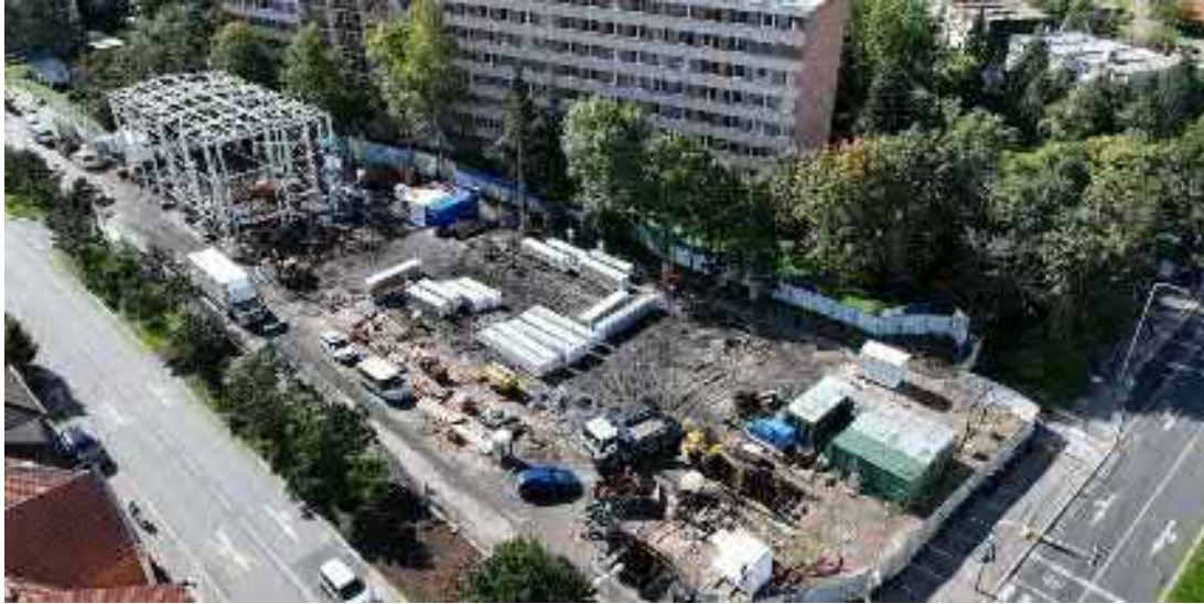
Výstavba protihlukové haly pro hloubení stanice 10/2022
