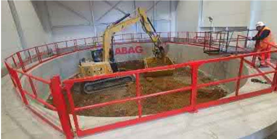
Zahájení hloubení v protihlukové hale 11/2022
