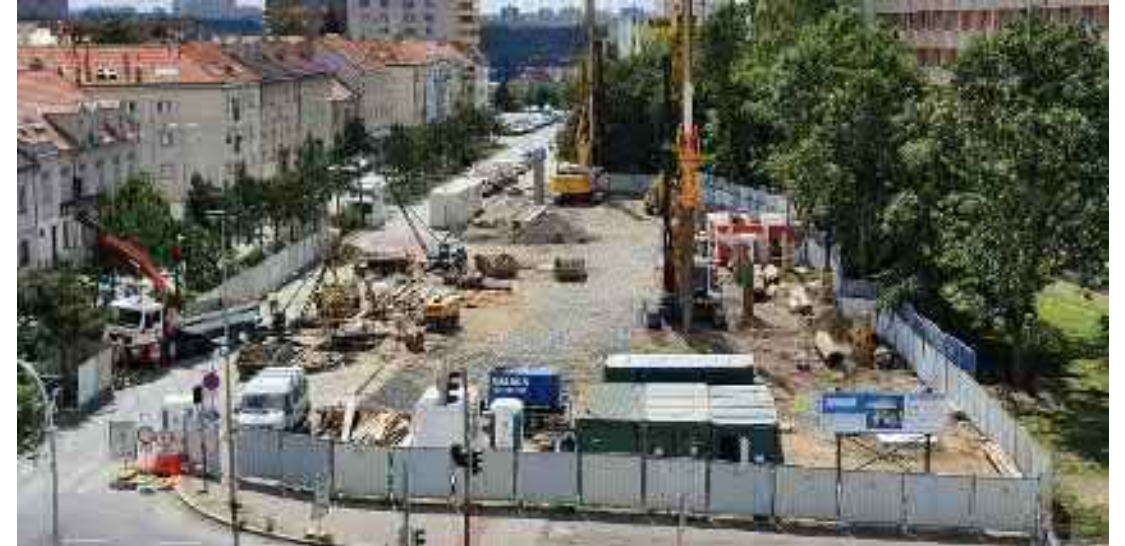
Vrtání pilot vestibul sever a šachta pro výstavbu stanice 08/2022
