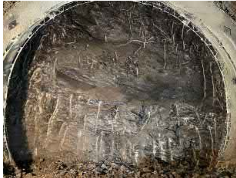
tektonicky porušené bohdalecké břidlice
