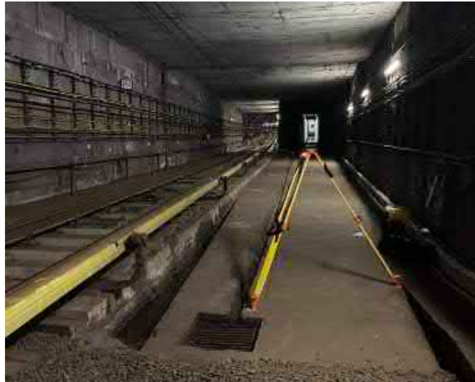
geodetické měření v metru C
