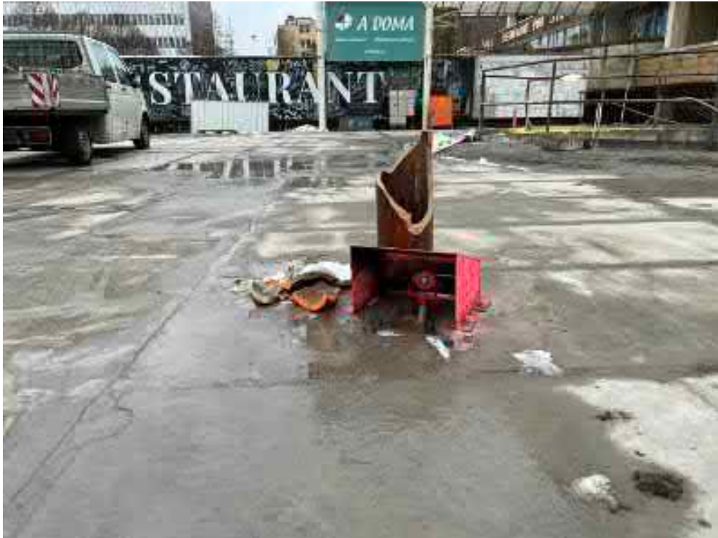
geodetické měření IS
