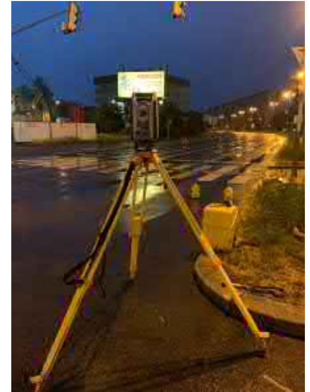
geodetické měření na povrchu
