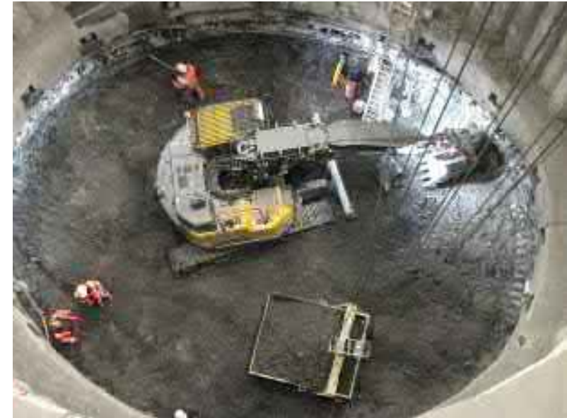
silně podrcené břidlice při hloubení šachty pro výstavbu stanice Olbrachtova
