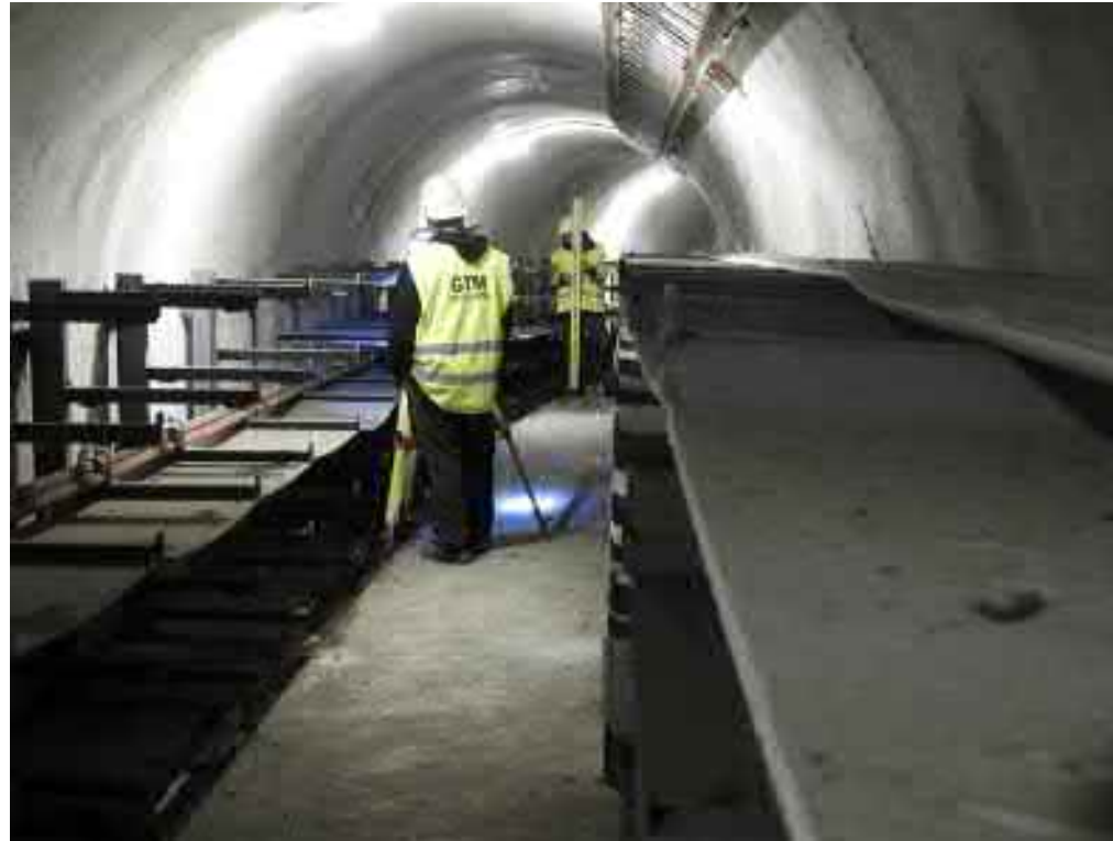
geodetické měření v kabelovodu
