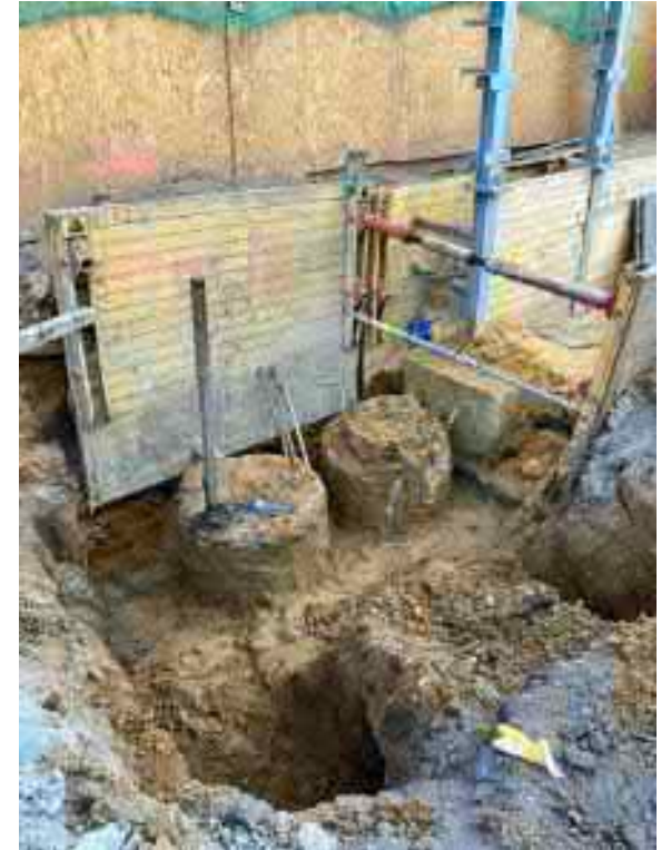
inclinometr v pilotě
