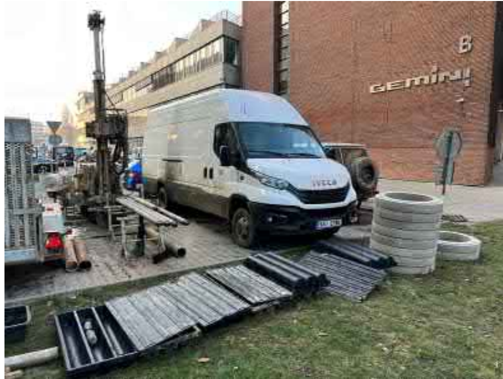
realizace vrtu monitoringu
