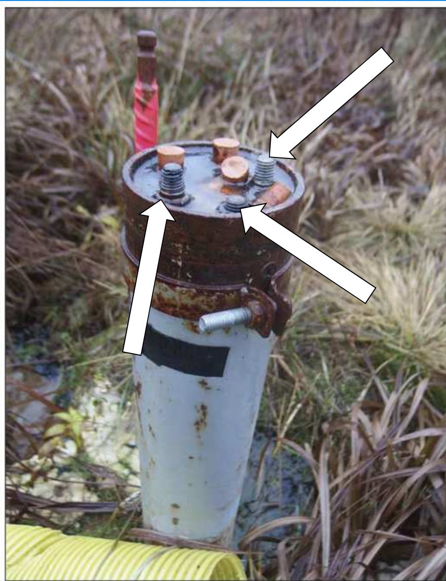
Detail zhlaví jednoho z extenzometrů
