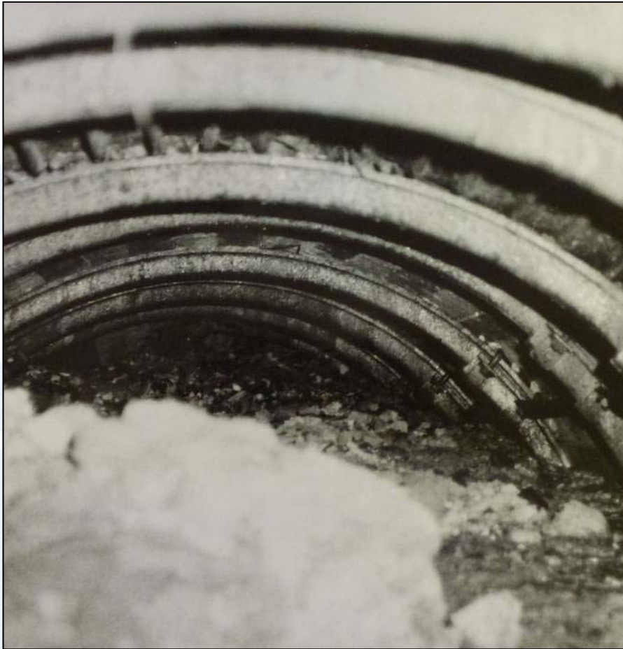
2.7. 1981 došlo při ražbě stoky „P“ k průvalu zvodnělých zemin výplně 100 m hluboké krasové deprese
