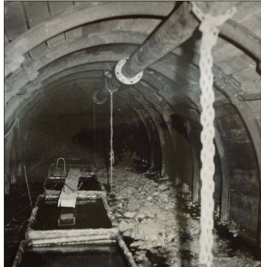
Průvalem vytvořený „splat“ – plochý kužel dosahoval délky 140-150 m od čela výrubu a zavalil i důlní vozíky
