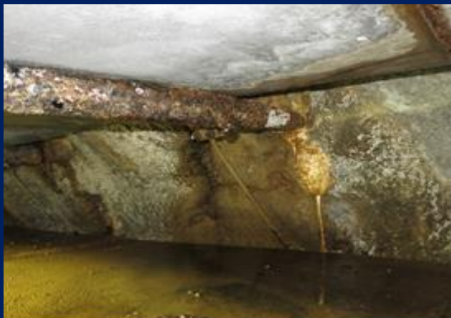
Detail výronů vody kolem konzol
