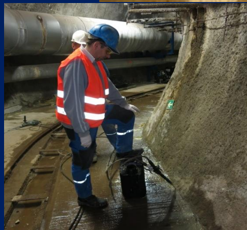
Injektáž paty ostění kolektoru proti průniku podzemní vody
