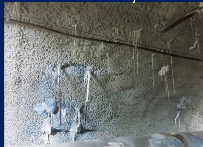
Sít trhlin s výluhy, lokální sanace kolem ocelových konzol
