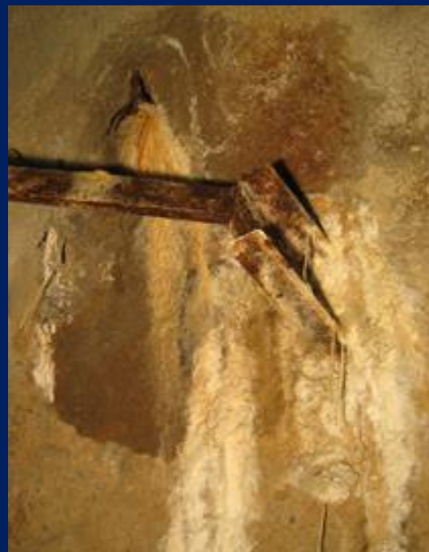
Detail výronů vody kolem konzol
