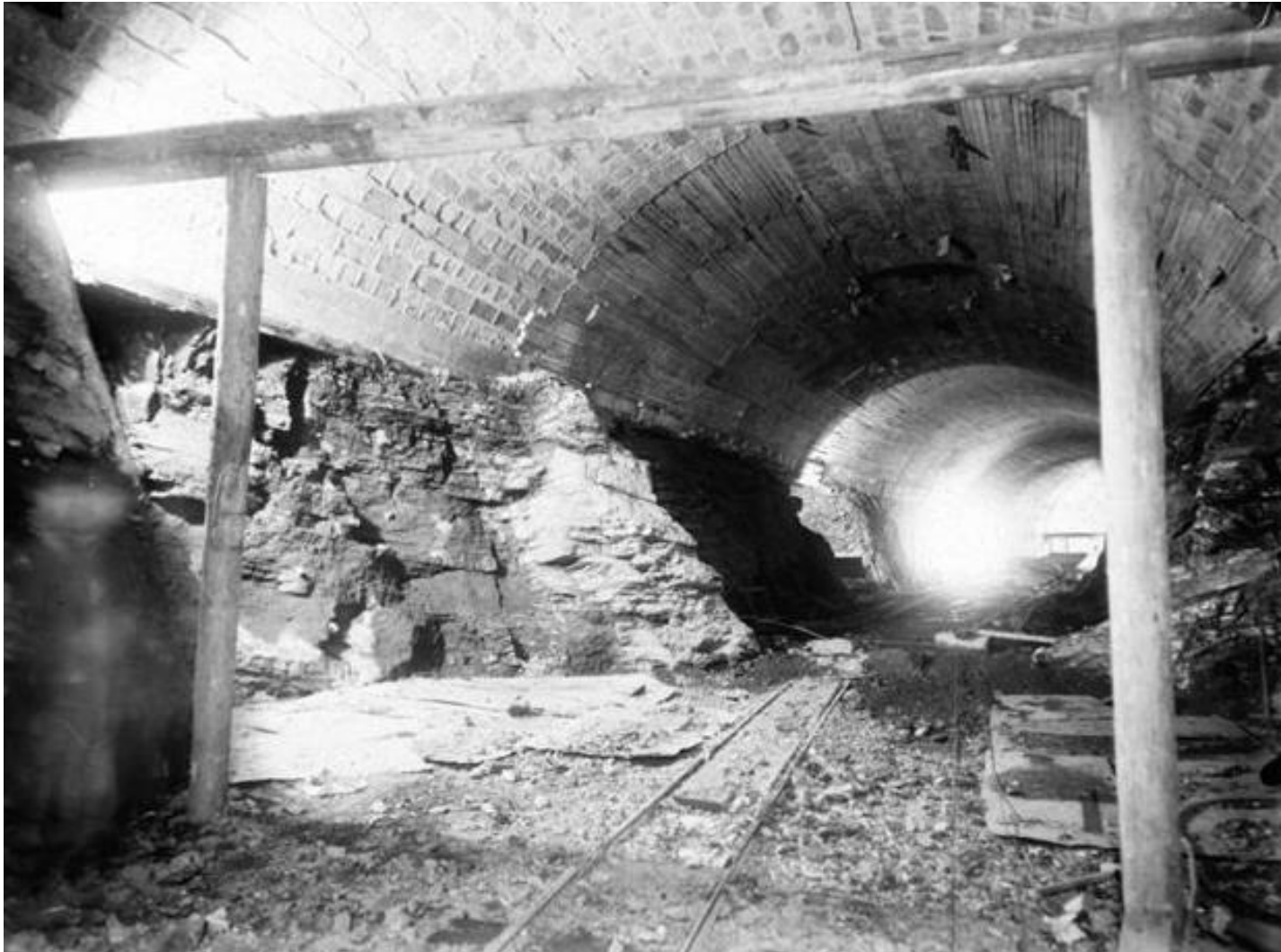
Provádění opěr
