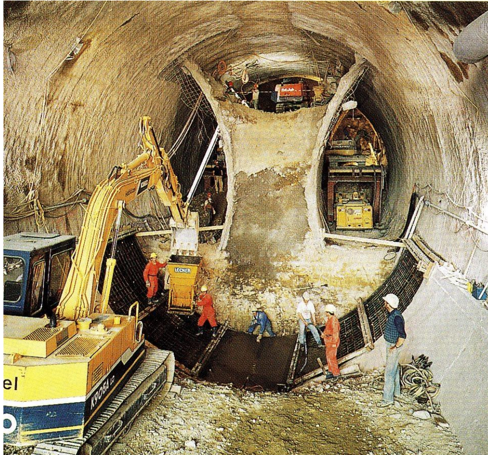
Fasenschaub Tunnel – dálnice A4 v kantonu Schaffhausen
