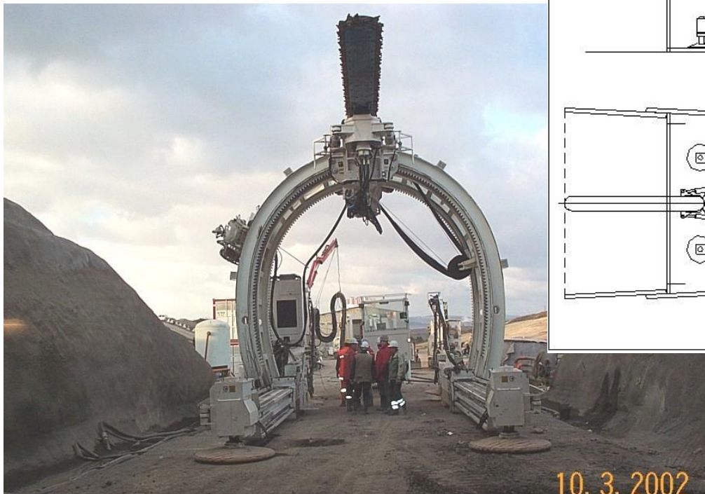
Vrubovací stroj PERFOREX na tunelu Březno
