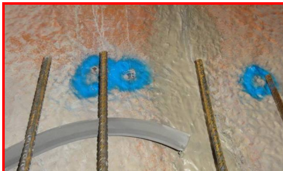
Porušení izolace prutem ocelové výztuže
