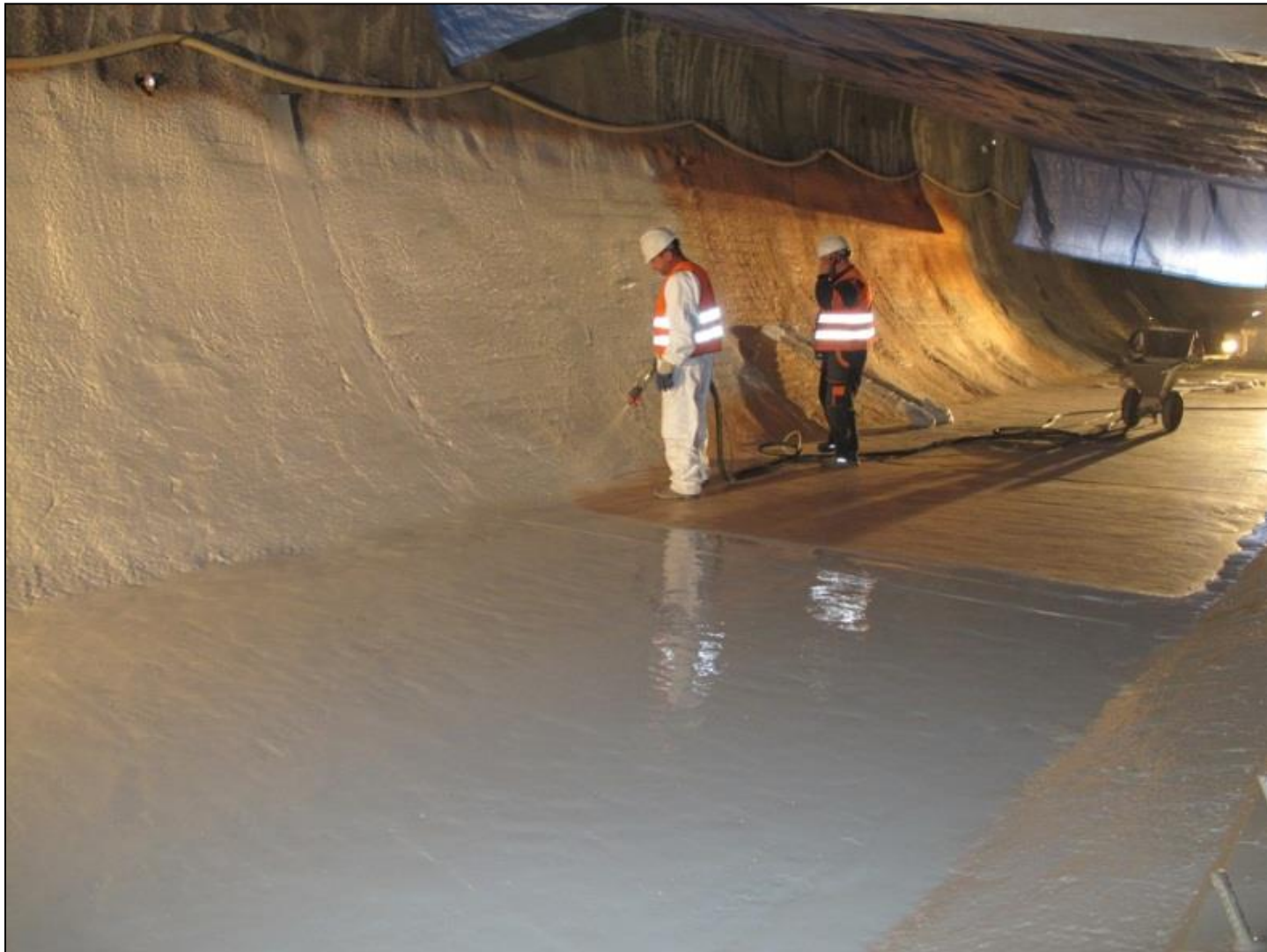
Aplikace finální vrstvy stříkané izolace – tunelové dno
