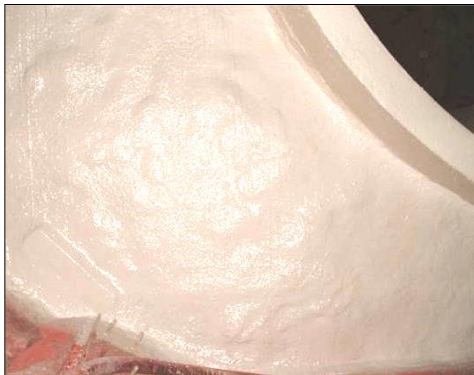
Čelo stanice – detail SHI (2. nosná vrstva)
