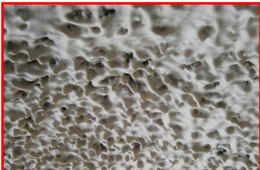
Nekompaktní povrch izolace
