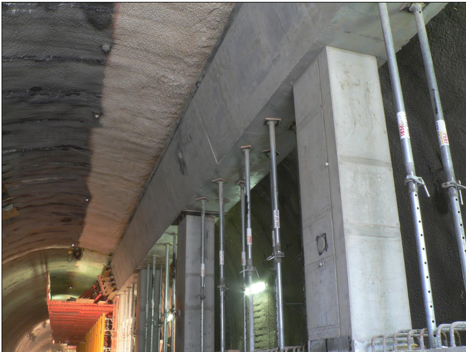
Přesah izolace z prostoru pod trámem pro napojení izolace klenby
