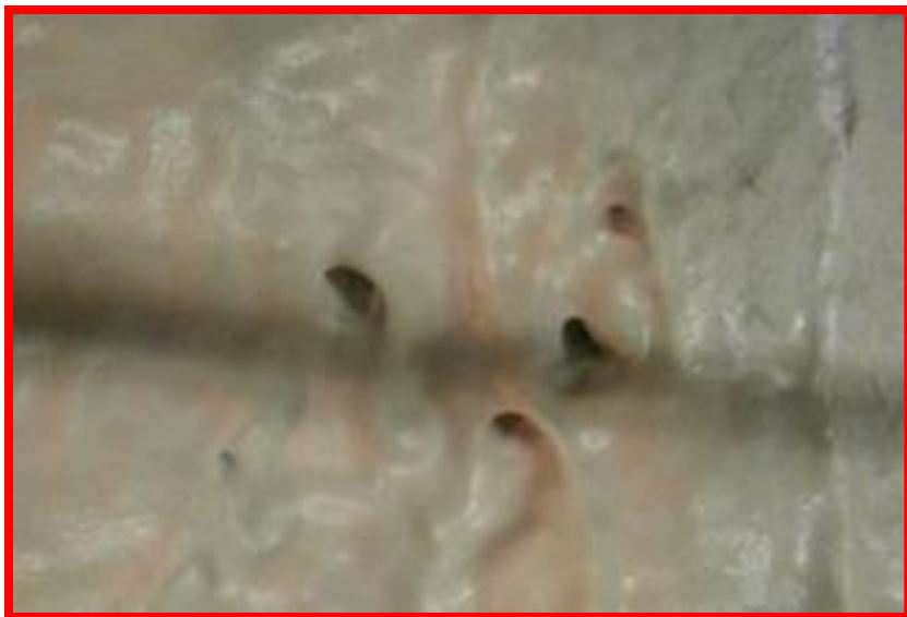
Nekompaktní povrch izolace
