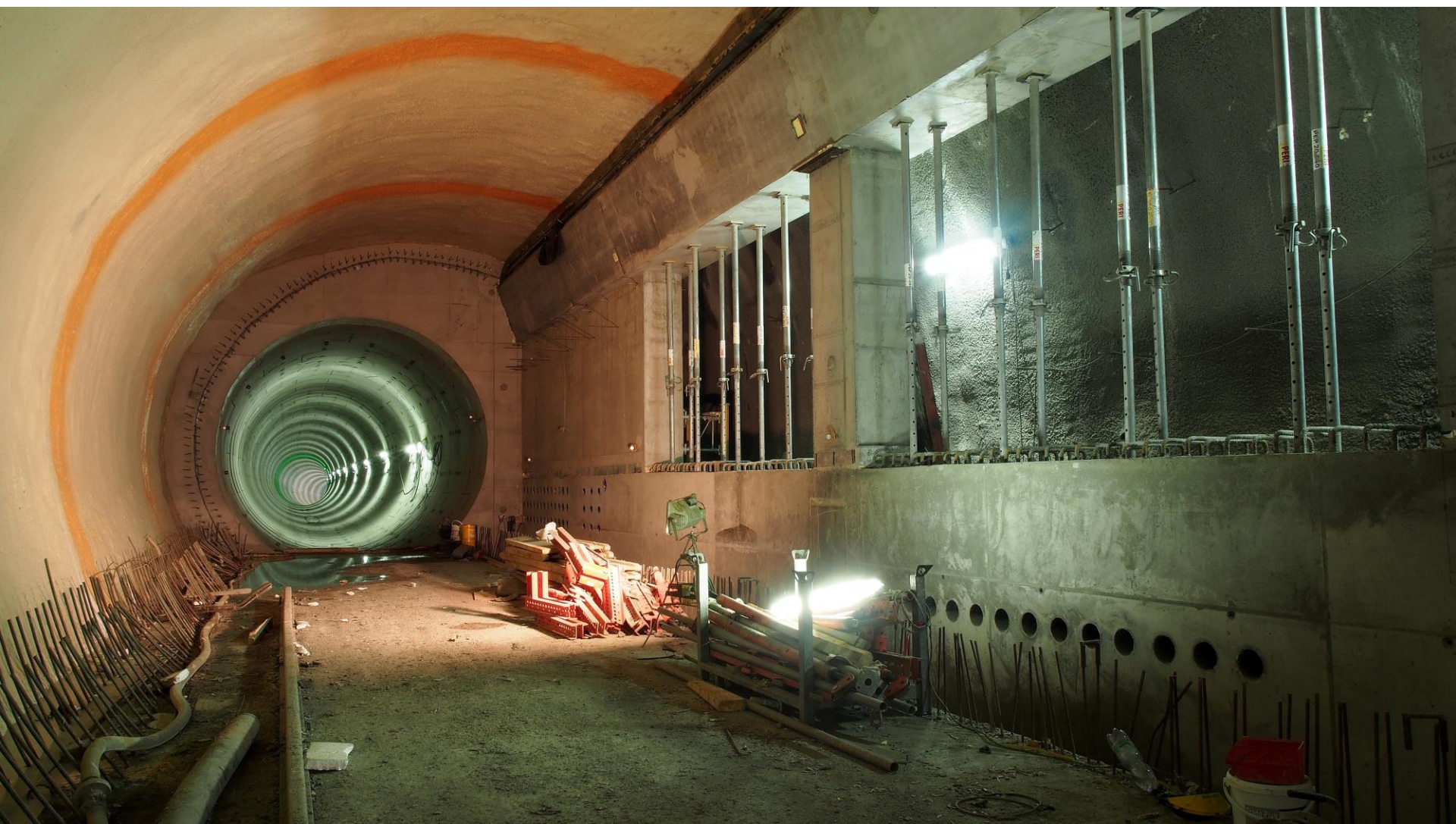
Finální vzhled izolace – úspěšné zvládnutí nové technologie izolování podzemních děl
