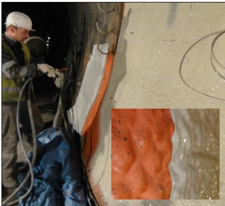
Zkouška aplikace stříkané izolace od společnosti BASF (detail - barevná odlišnost mezi první a druhou vrstvou izolace)
