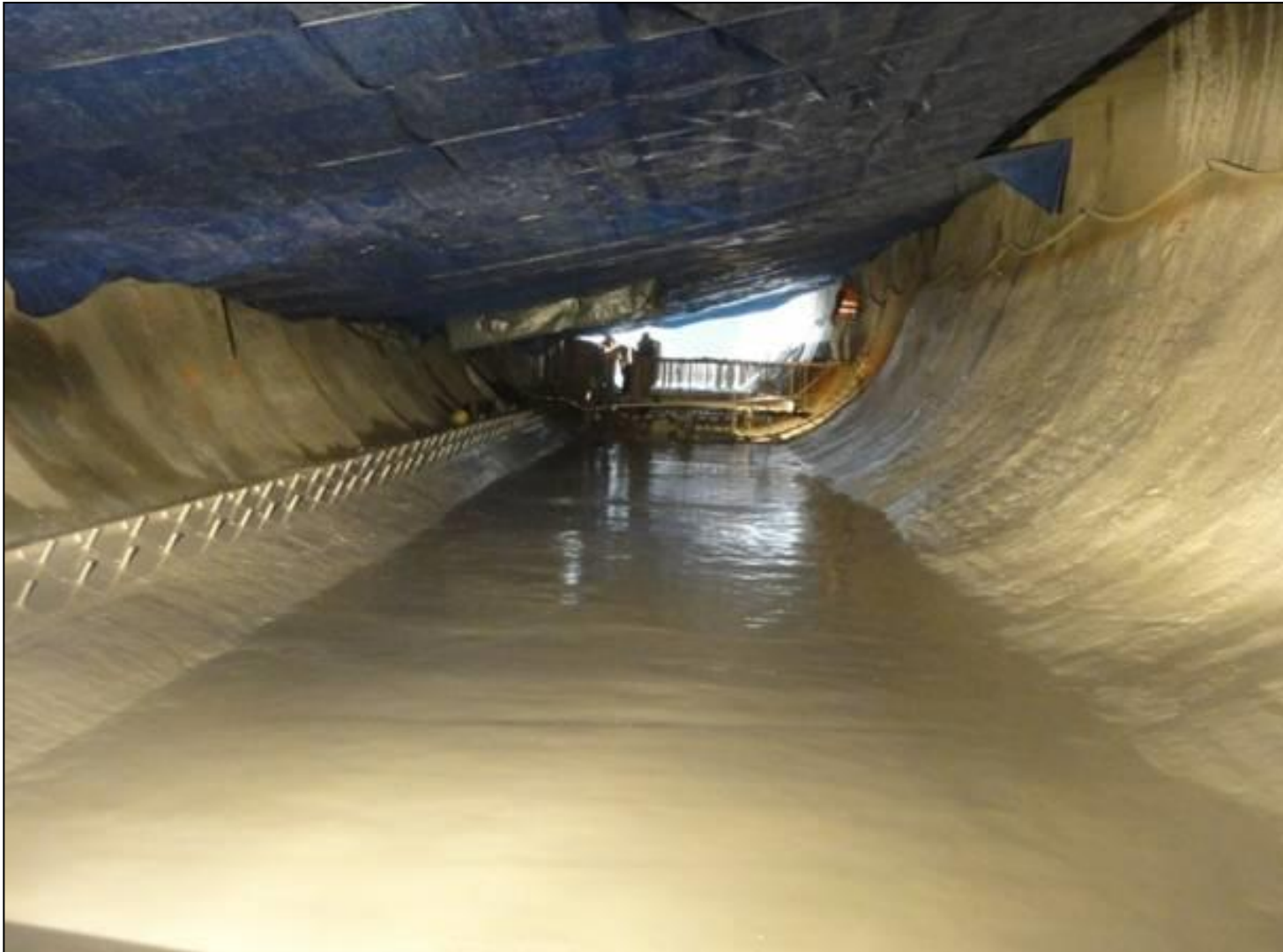
Stříkaná izolace v protiklenbě s přesahem pro nástřik v kalotě tunelu
