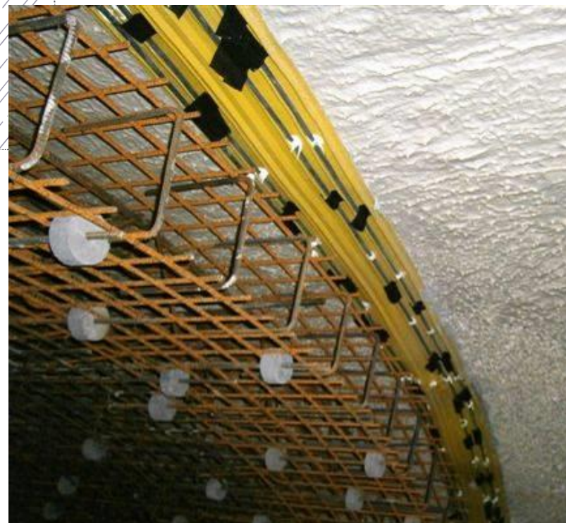
Detail řešení dilatační spáry – vně uložený spárový pás s injekčním systémem
