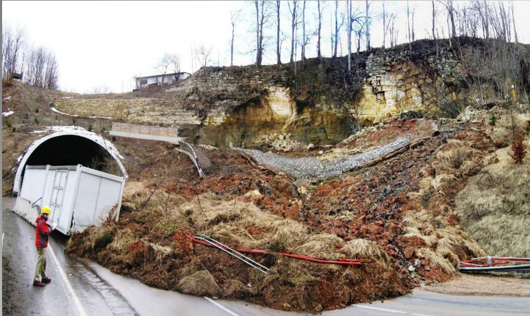
Zavalení silnice I/35 před portálem
