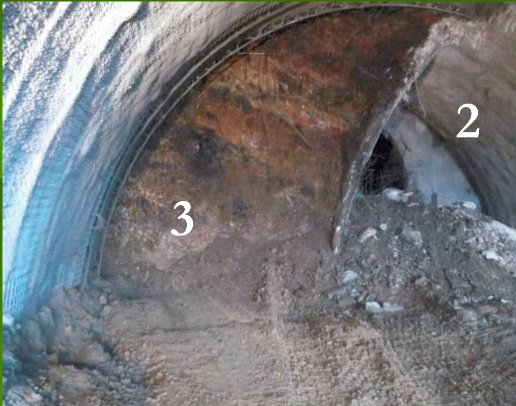
Dílčí výrub 3 kaloty LTT - tkm 110,0 (zvětralé tufy)
