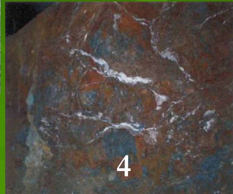
Dílčí výrub 4 - opěří pravé tkm 105,0 (zvětralý tuf a bazalt s kalcitem)
