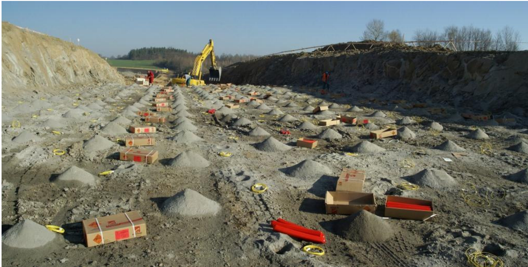
Tunelářské odpoledne 23.3.2011 – Zkušenosti z výstavby hloubeného Votického tunelu
