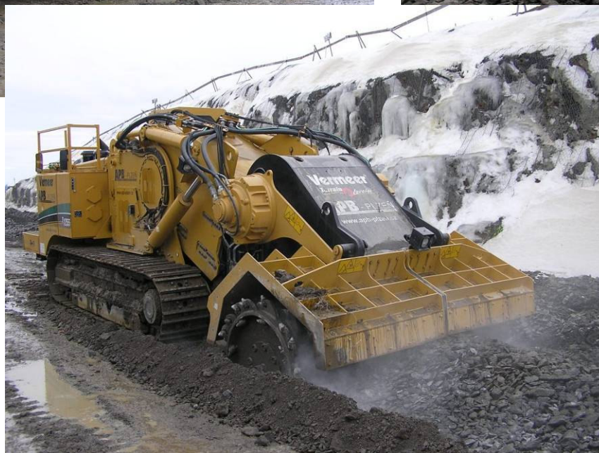
Tunelářské odpoledne 23.3.2011 – Zkušenosti z výstavby hloubeného Votického tunelu
