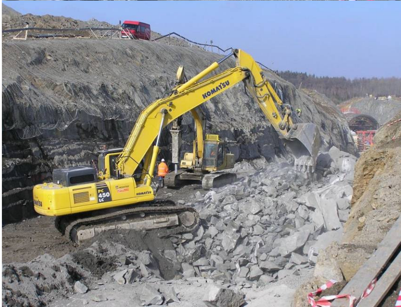
Tunelářské odpoledne 23.3.2011 – Zkušenosti z výstavby hloubeného Votického tunelu
