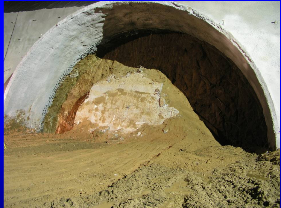
Jižní portál – stav z dubna 2010
