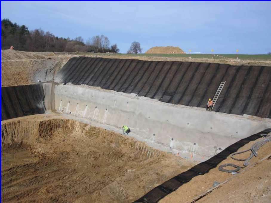
Jižní portál – stav z března 2010
