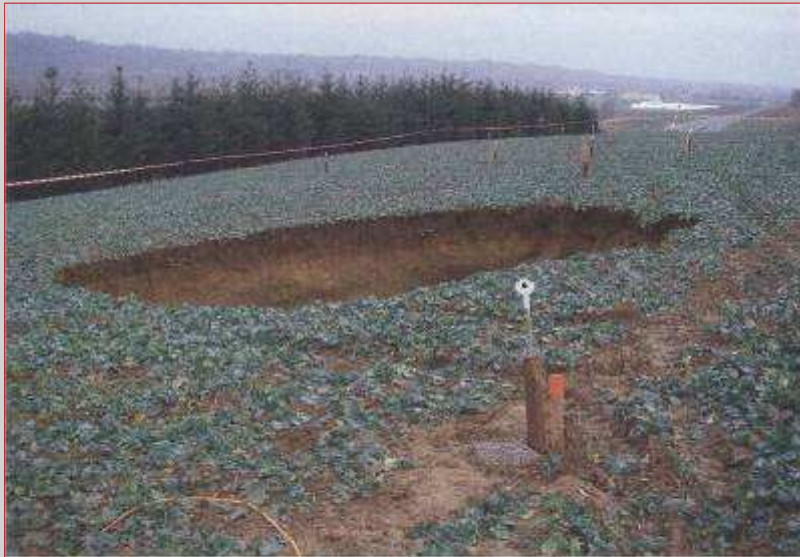
Fig. 8. Chimney up to the surface Bild 8. Ausbildung Tagbruch an der Oberfläche
