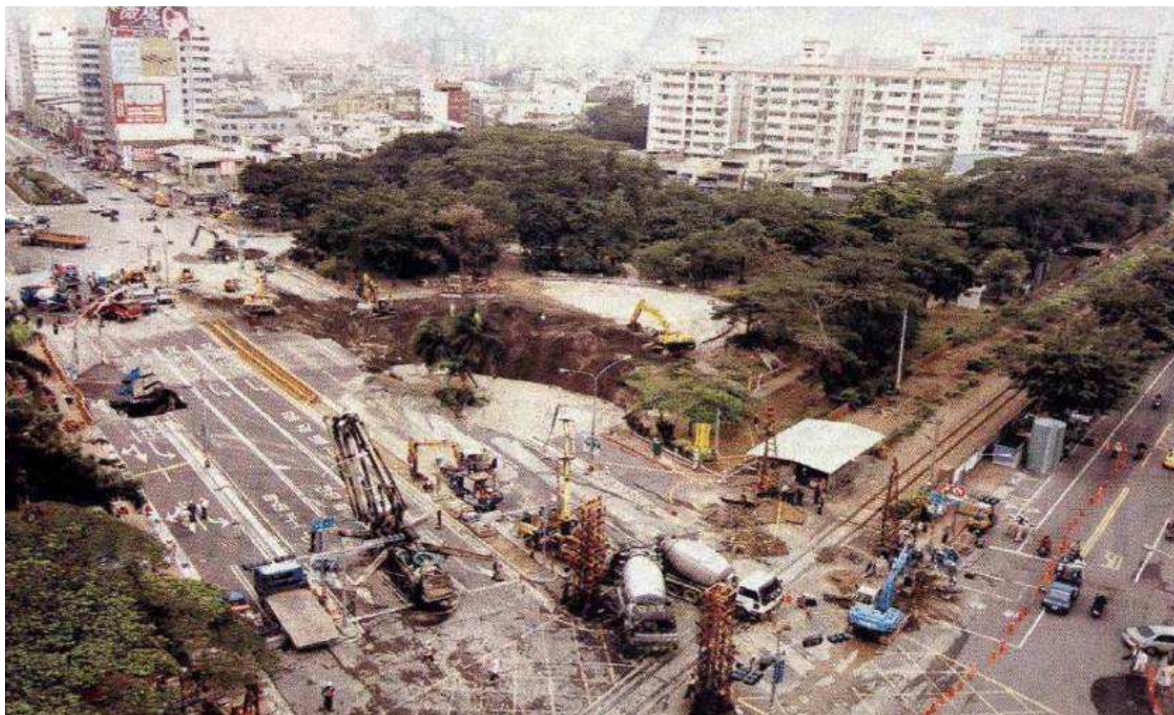
Kráter vzniklý při havárii tunelu Kaohsiung –Taiwan 2005
