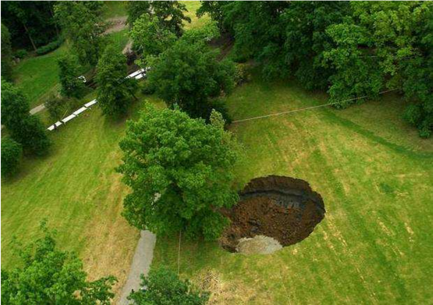
Kráter vytvořený po první havárii na tunelu Blanka
