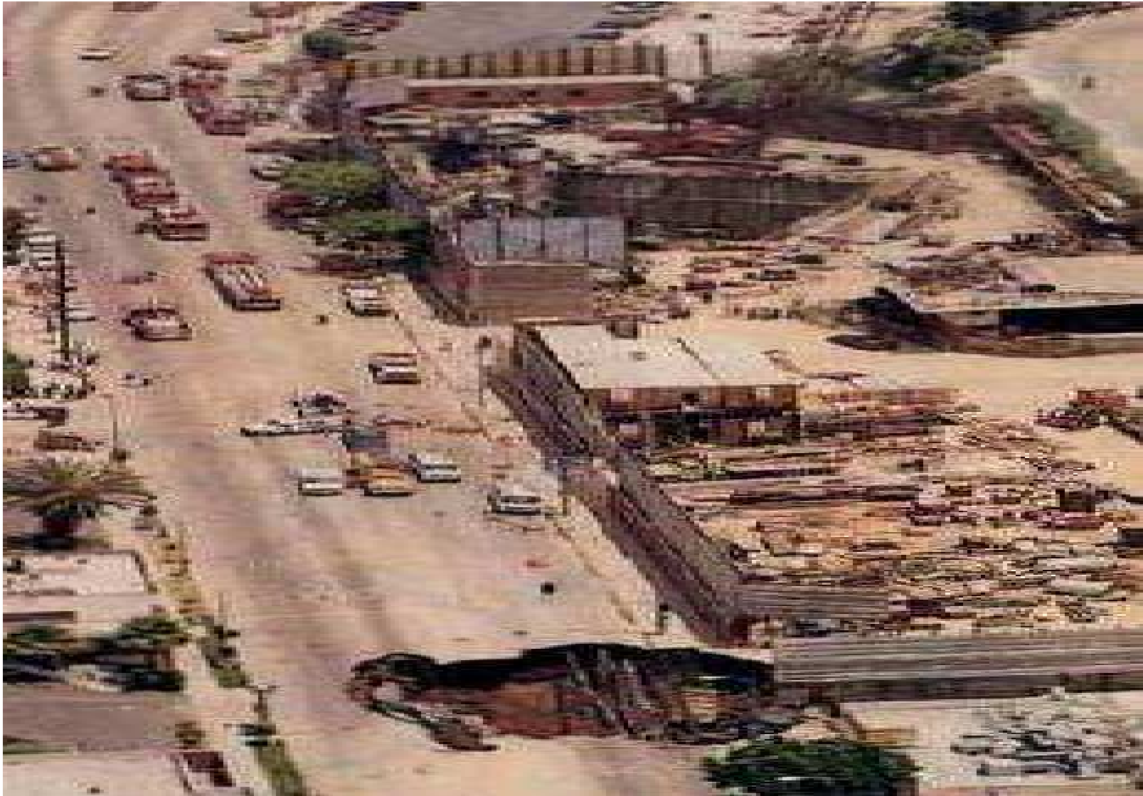
Havárie metra v Los Angeles v roce 1995, Los Angeles (USA)
