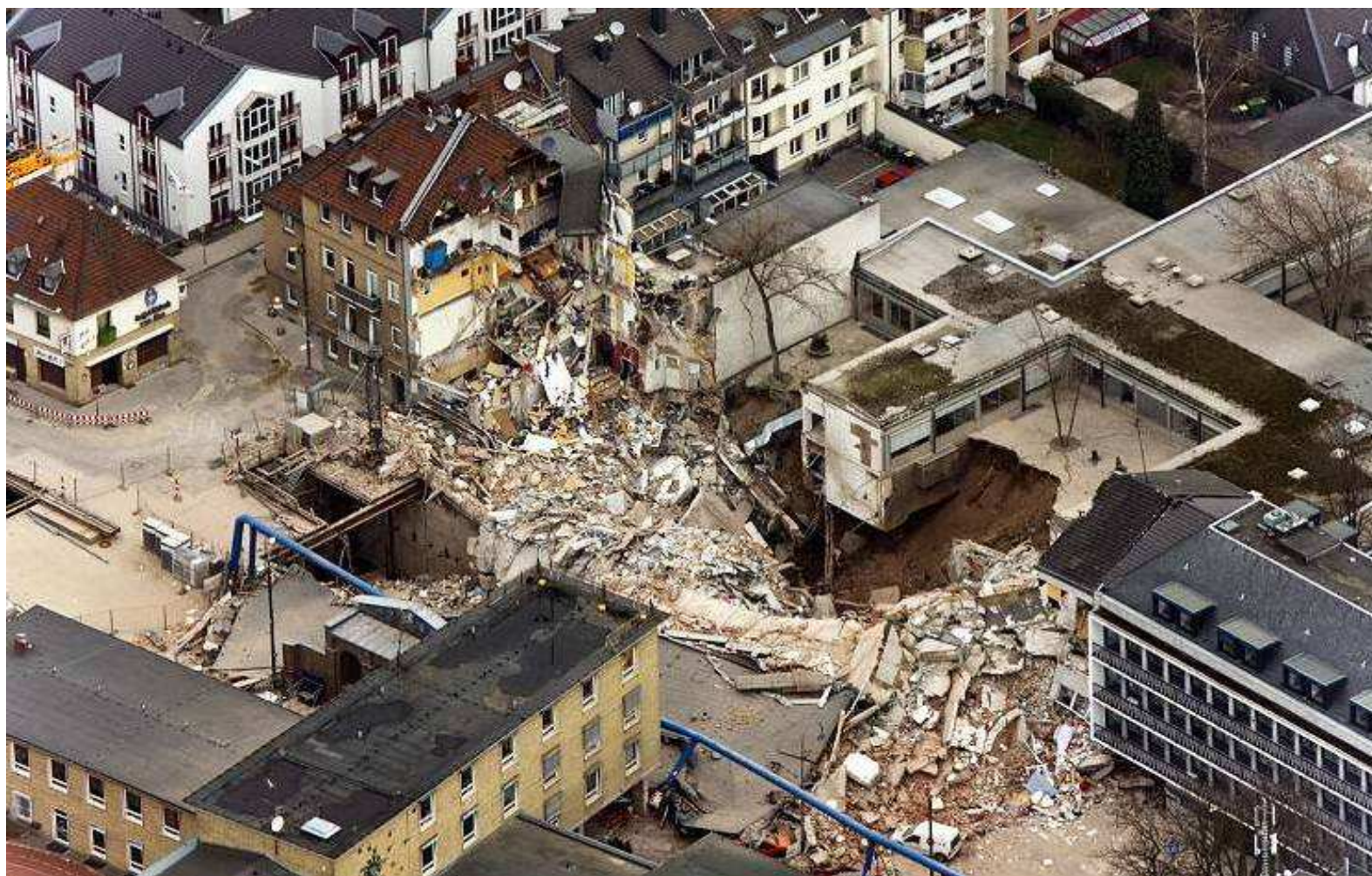
Trosky budovy historického archivu zničeného následkem havárie stavební jámy v Kolíně nad Rýnem - 2009
