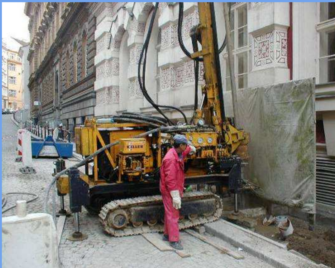
Podchycení základů tryskovou injektáží
