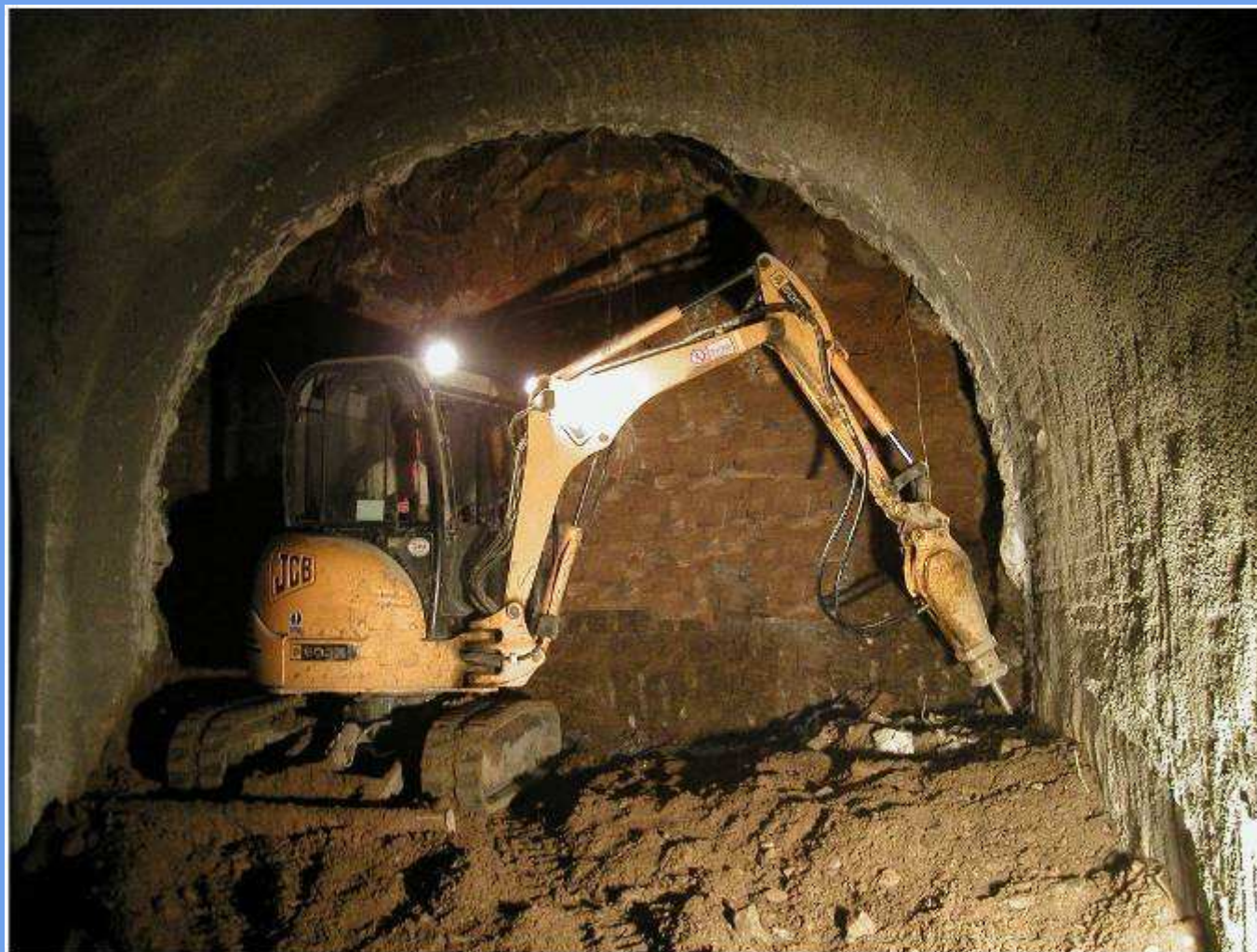
Ražba kolektoru a vystrojení primárním ostěním
