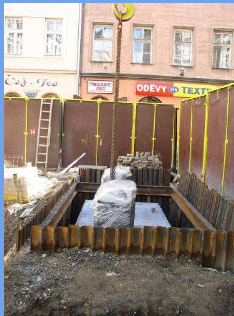
Podzemní velkokapacitní kontejnery
