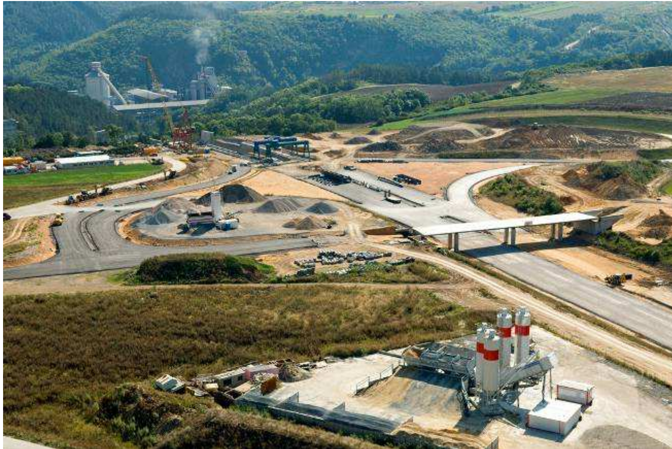
staveništní betonárna pro výstavbu tunelu u Lochkova
