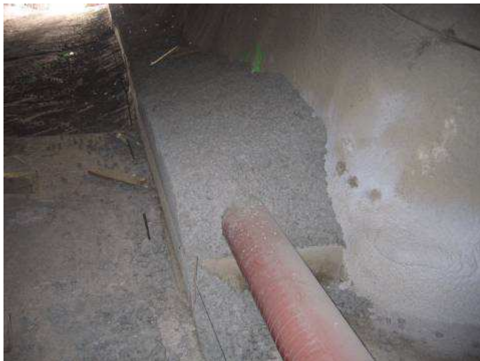
Drenáž zabudovaná v jednozrnném betonu
