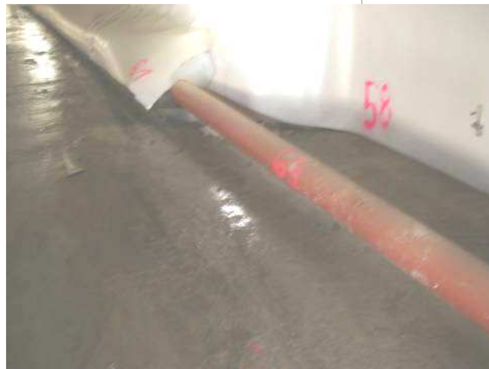
Přechod přes výklenek plnostěnnou rourou
